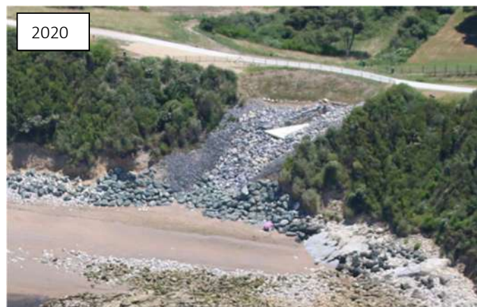
Illustration 47 - Secteur ouest d'Erromardie après confortement et revégétalisation (©Observatoire de la Côte Aquitaine, Olivier Chaldebass, ULM Sud Bassin, 2020)
