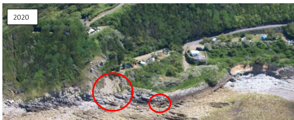
Illustration 41 - Zones d'érosion, à l'extrémité nord de la plage de Lafiténia (@Observatoire de la Côte Aquitaine, Olivier Chaldebas, ULM Sud Bassin, 2020)
