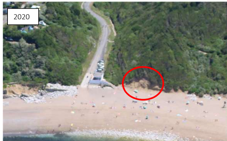
Illustration 43 - Zones d'érosion, en partie centrale de la plage de Lafiténia ; à noter que la masse glissée visible sur l'illustration 42 n'est pas identifiable sur ce cliché daté du 25/07/2020, le glissement s'est vraisemblablement produit entre fin juillet et novembre 2020 (@Observatoire de la Côte Aquitaine, Olivier Chaldebais, ULM Sud Bassin, 2020)
