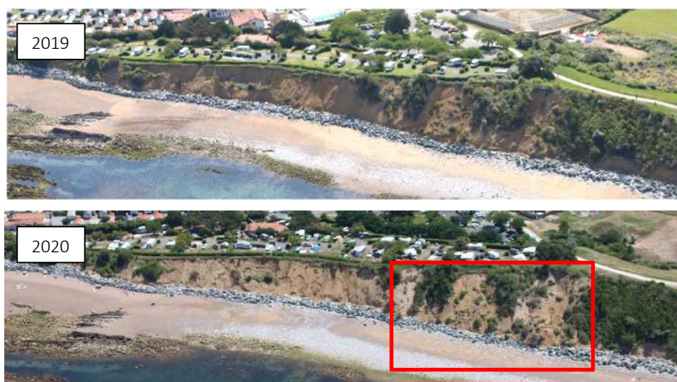
Illustration 49 - Versants ouest d'Erromardie, en proie à une dynamique de glissement de terrain généralisée ; identification des deux sous-secteurs plus actifs au cours de la période 2019-2020 (@Observatoire de la Côte Aquitaine, Olivier Chaldebais, ULM Sud Bassin, 2019 et 2020)
