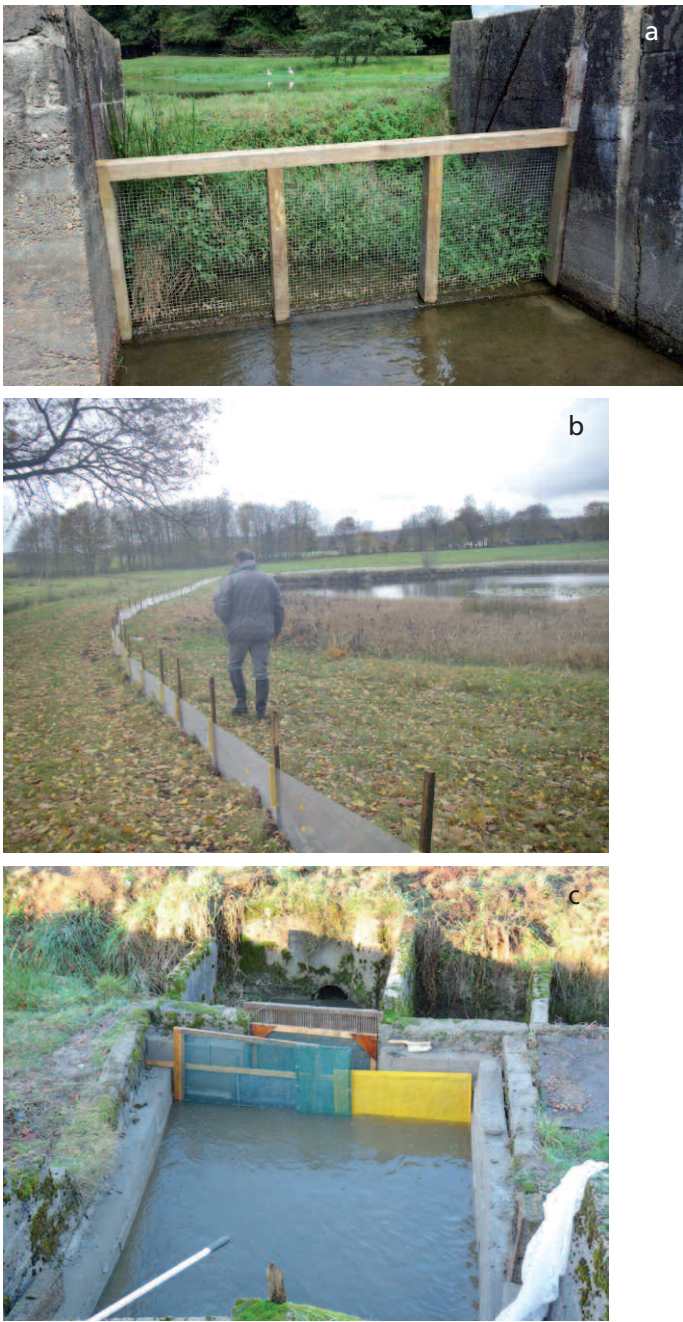
a) la mise en place de barrages filtrants permet d'éviter la dissémination de boutures de plantes aux tiges fragiles, comme ici l'Hydrocotyle fausse-renoncule. Pour la faune, la mise en place de barrières physiques (barrière de piégeage et systèmes de filtration) est nécessaire pour éviter toute dispersion de l'espèce gérée, comme ici l'Écrevisse de Louisiane. b) mise en place d'une barrière autour d'un étang ; c) système de filtration dans la pêcherie d'un étang.
