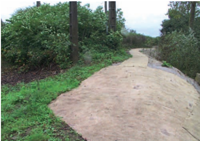
Pose de bâches et mise en place de boutures de saule pour la gestion de la renouée.
