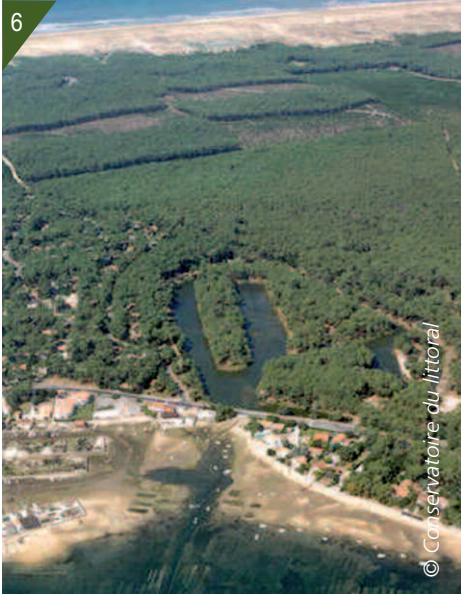
6- Vue aérienne des réservoirs du Pirailan.
