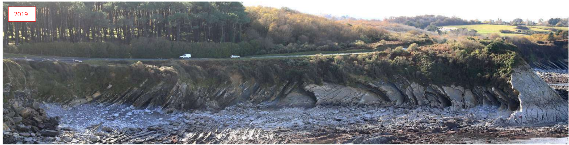
Illustration 42 - Vue générale du tronçon 19 lors de la campagne du 26/11/2019 (©Observatoire de la Côte Aquitaine, Balloide Photos, 2019)
