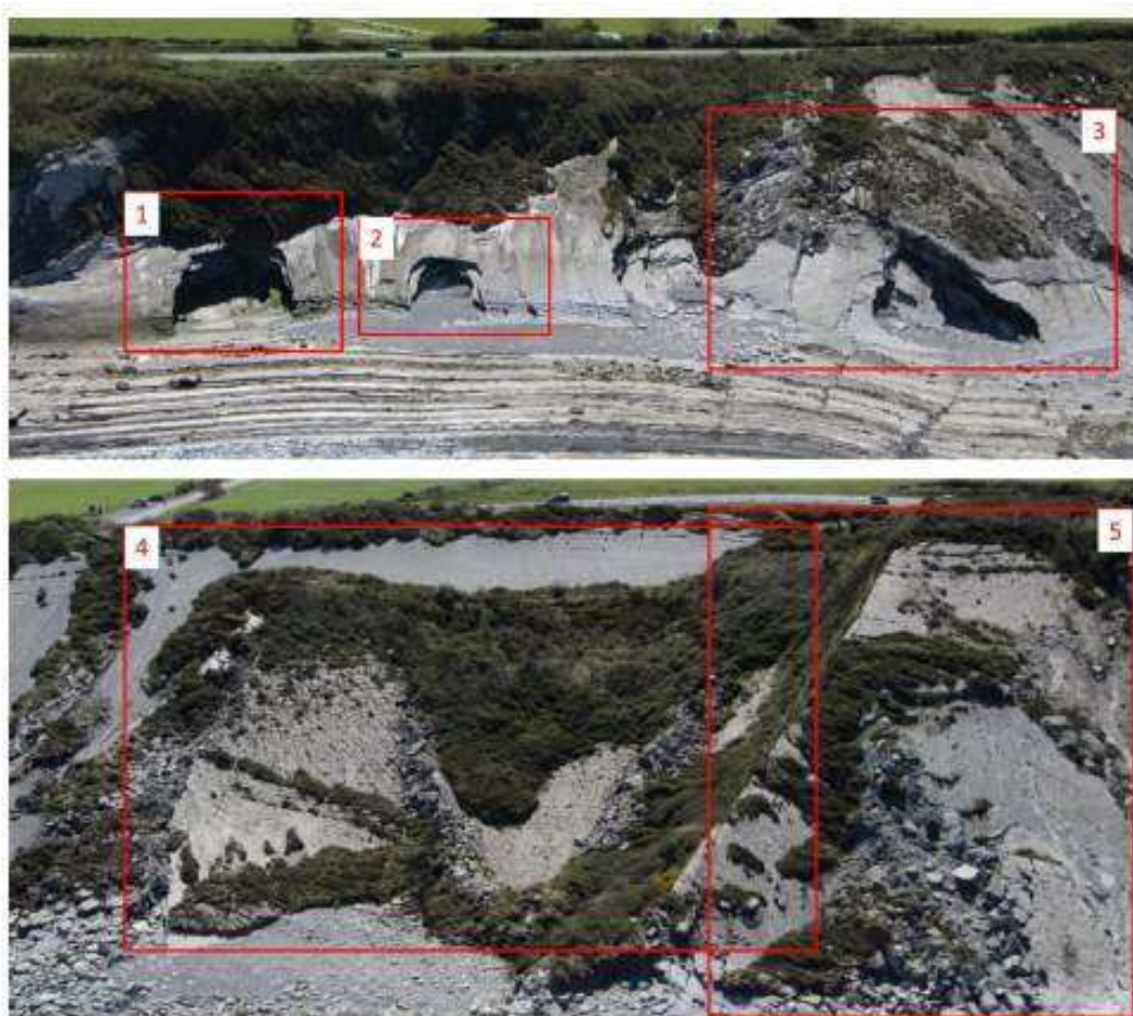
Illustration 27 - Vue d'ensemble du tronçon 15 avec identification des zones de détails ; zones 1 à 3 : cavités formées par ablation en pied de paroi, zones 4 et 5 : activité "glissement de terrain" active ou suspectée (©Observatoire de la Côte Aquitaine, Balloide Photos, 2014)
