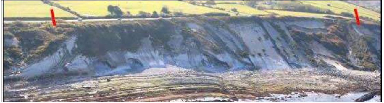
Illustration 26 - Vue d'ensemble du tronçon 15 lors de la campagne de novembre 2016 (©Observatoire de la Côte Aquitaine, Balloide Photos, 2016)
