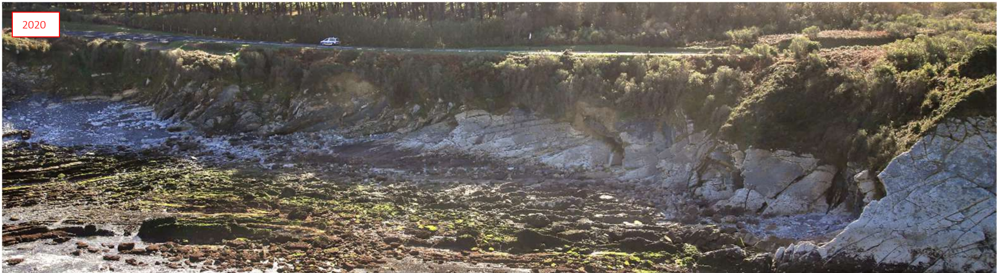
Illustration 43 - Vue générale du tronçon 19 lors de la campagne du 17/11/2020 (©Observatoire de la Côte Aquitaine, Balloide Photos, 2020)
