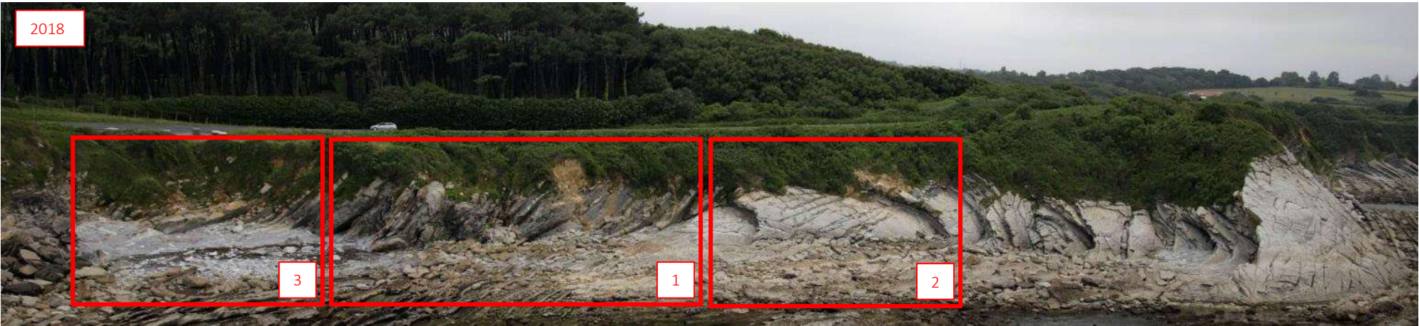
Illustration 41 - Vue générale du tronçon 19 lors de la campagne du 27/06/2018 (©Observatoire de la Côte Aquitaine, Balloide Photos, 2018)
