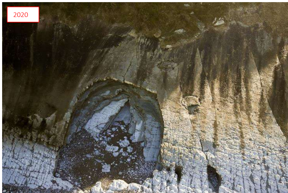
Illustration 29 - Vue de détail du tronçon 15 : absence d'évolution significative constatée dans la zone 2, entre les campagnes du 27/06/2018 et du 17/11/2020 (©Observatoire de la Côte Aquitaine, Balloide Photos, 2018, 2019 et 2020)
