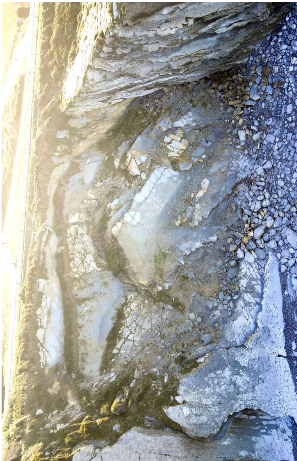
Illustration 15 - Vue générale du tronçon 7 lors de la campagne du 17/11/2020 (©Observatoire de la Côte Aquitaine, Balloide Photos, 2019)
