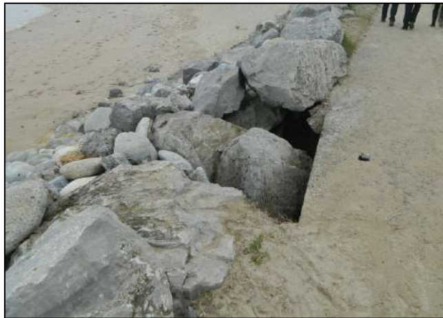
Figure 50 : Désordres sur l'enrochements de Mouriscot et sous-cavage de la promenade (ouvrage n°4), plage d'Ilbarritz (© Observatoire de la Côte Aquitaine, 10 janvier 2013).
