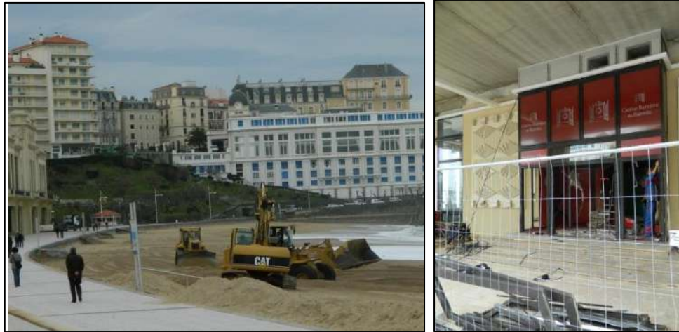
Figure 54 : Gauche : remodelage du sable sur la Grande plage faisant suite à son utilisation pour le merlon de protection du casino ; Droite : réparation des baies vitrées du casino, détruites dans la nuit du 6 au 7 janvier (Biarritz, 09/01/2014, BRGM).
