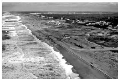
Figure 1. Destruction du mur de soutènement en 1971
