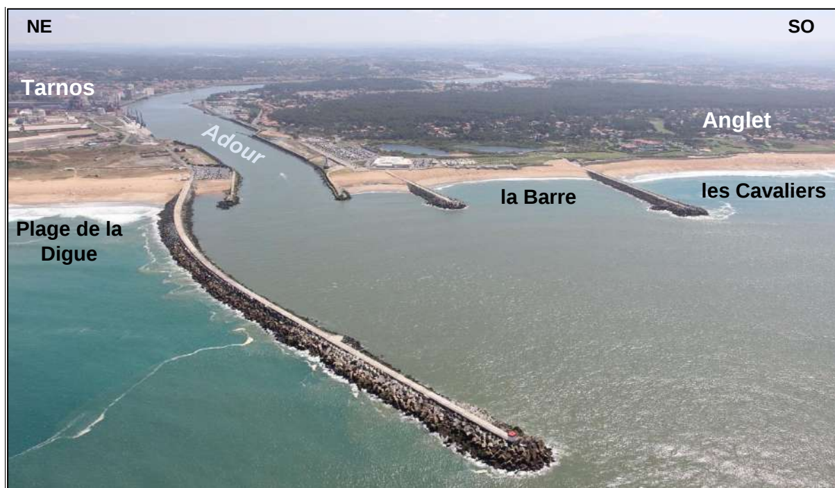
Figure 3 : Dignes en enrochements sur l'embouchure de l'Adour (© Observatoire de la Côte Aquitaine, Michel Le Collen, août 2013).
