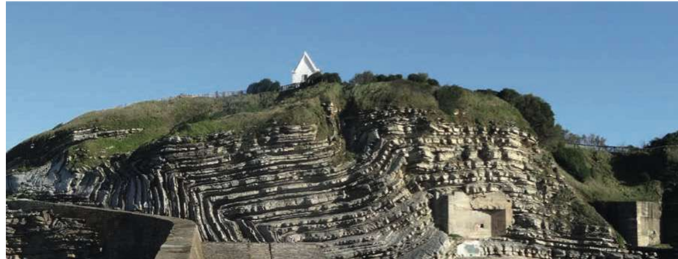
Le célèbre « pli en genou » dans les sédiments crétacés du flysch, sur le flanc nord de la baie de Saint-Jean-de-Luz. © Jacques Maillos
