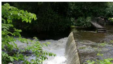
Barrage du Pont Barsac, Ciron Source : SAGE Ciron, Amélioration des continuités écologiques des cours d'eau en Nouvelle-Aquitaine
