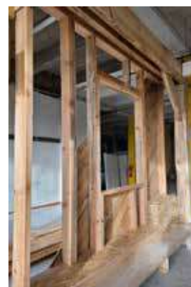
Préparation à la prochaine formation ossature bois source : IFABE
