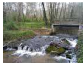
Seuil de Tiquetorte - avant travaux d'arasement
