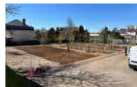
Mise en œuvre du projet de re-végétalisation – lycée Valadon (Limoges)
