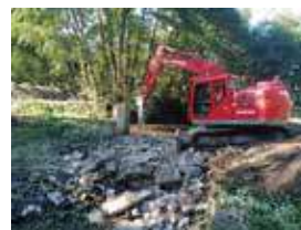
Seuil de Tiquetorte - intervention pour arasement
