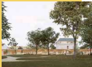
Construction d'une média-ludothèque (Neuville-de-Poitou, 86)
