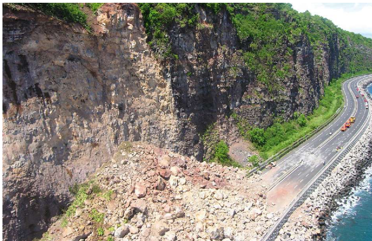
◀ Éboulement en masse de la falaise sur la RN1 dite route du littoral (La Réunion, mars 2006). © IFSTTAR
