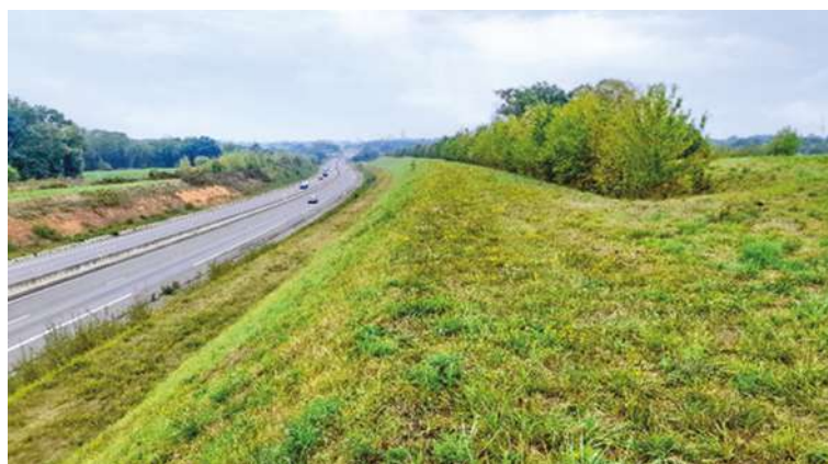
Figure 3-13 : Dépendances vertes routières (Cerema)
