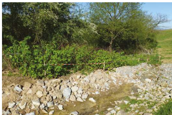
Figure 4-8 : Phase travaux : balisage (J. Biaunier/Cerema)
