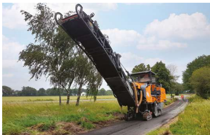
Figure 4-9 : Phase déconstruction (Cerema)
