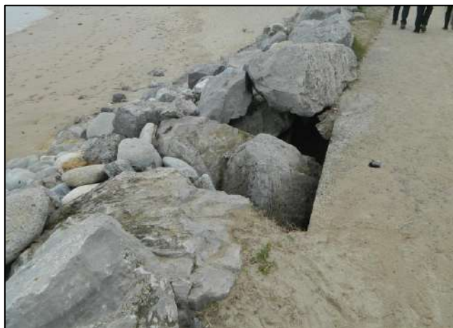
Figure 50 : Désordres sur l'enrochements de Mouriscot et sous-cavage de la promenade (ouvrage n°4), plage d'Ilbarritz (© Observatoire de la Côte Aquitaine, 10 janvier 2013).
