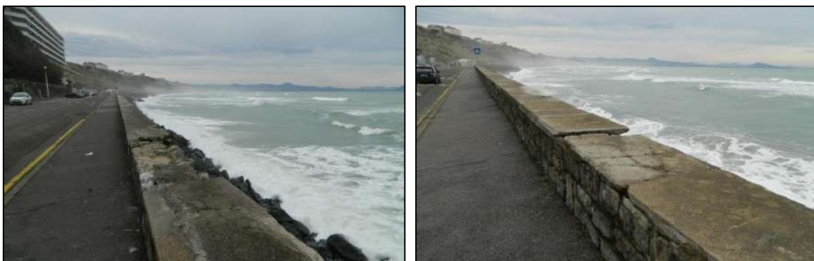
Figure 56 : Altération du parapet du perré au Nord de la Côte des Basques (Biarritz, 09/01/2014, BRGM).
