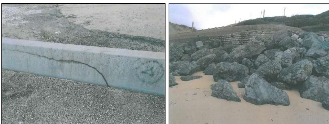
Figure 63 : Gauche : détérioration du parapet en béton à l'extrémité de la promenade ; Droite : fragilisation des enrochements sur la plage avec désolidarisation de plusieurs blocs (Bidart, 07/01/2014, Services Techniques, Mairie de Bidart).
