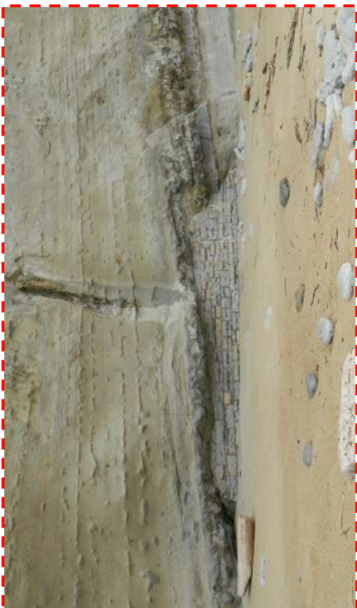
Figure 46 : Mur "bouclier" en maçonnerie sur une dizaine de mètres de large, obstruant une zone sous-cavée. Ouvrage n°5 (© Observatoire de la Côte Aquitaine, 30/10/2012).
