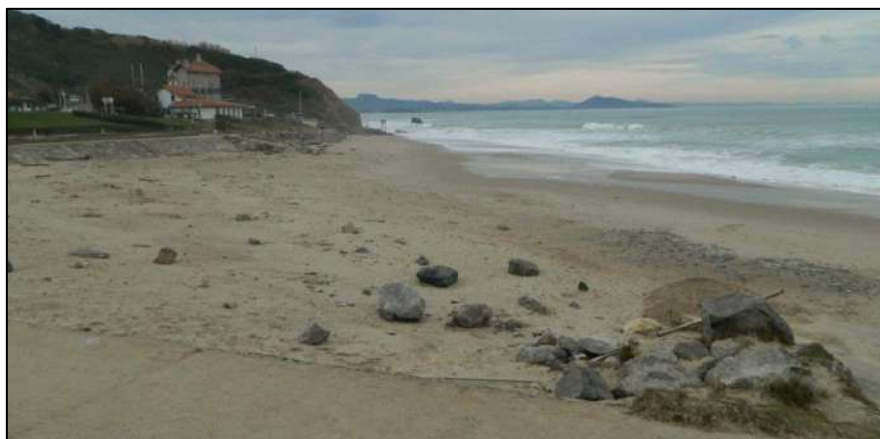
Figure 61 : Déstabilisation des enrochements, accès Nord, plage d'Ilbarritz (Bidart, 09/01/2014, BRGM).
