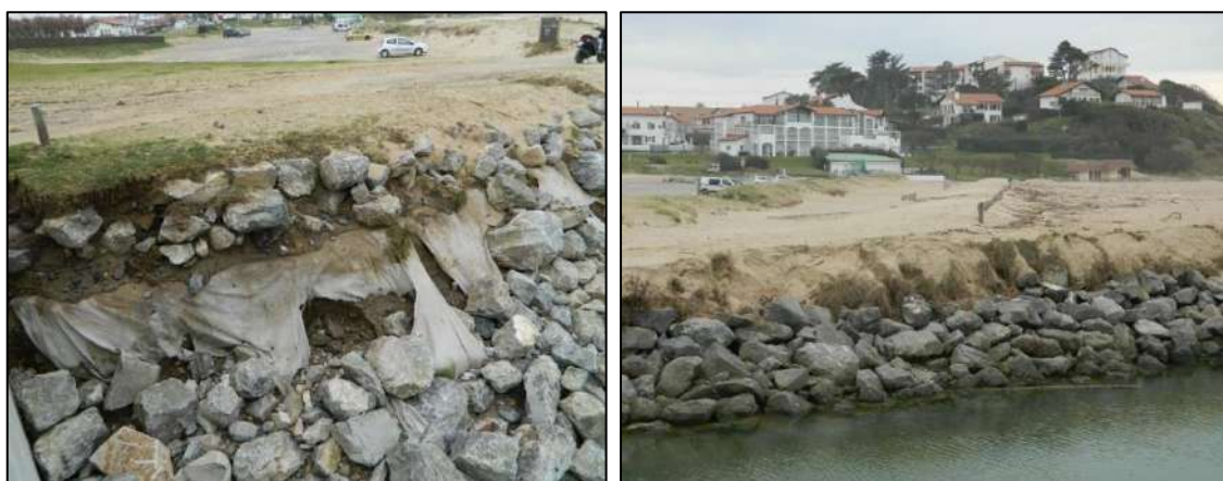
Figure 65 : Fragilisation des enrochements sur la rive gauche du débouché de l'Uhabia (Bidart, 09/01/2014, BRGM).
