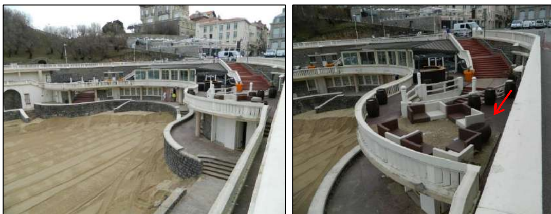
Figure 55 : Gauche : dégâts visibles sur le bâtiment, le parapet et les garde-corps du Port-Vieux ; Droite : laisse de mer (flèche rouge) atteignant la terrasse du restaurant (Biarritz, 09/01/2014, BRGM).
