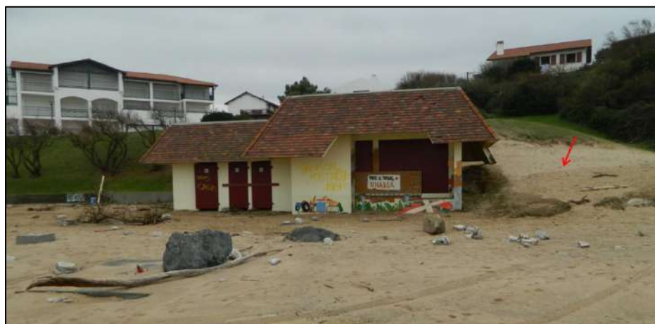
Figure 69 : Le poste de secours de la plage d'Uhabia a subi l'action du jet-de-rive. Le runup (hauteur maximale du jet-de-rive) est matérialisé par le sable plus foncé sur l'accès de plage (Bidart, 09/01/2014, BRGM).
