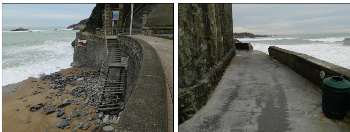
Figure 53 : Gauche : endommagement de l'escalier d'accès à la plage à l'extrémité Nord de la Grande plage ; Droite : destruction du parapet du perré au droit de l'Hôtel du Palais (Biarritz, 09/01/2014, BRGM).
