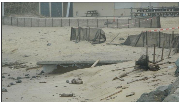
Figure 59 : Affouillement d'une dalle sur la plage de Milady (Biarritz, 09/01/2014, BRGM).
