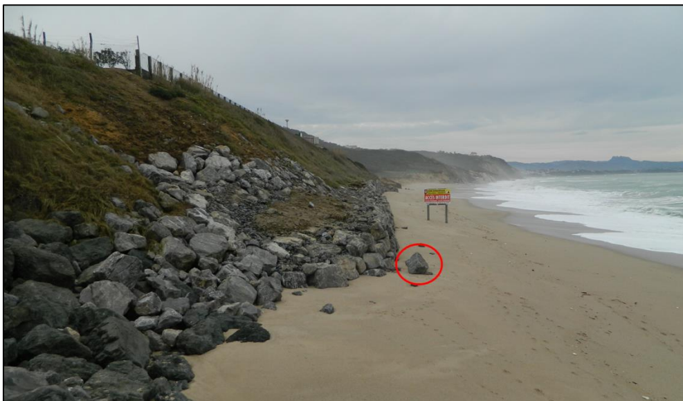
Figure 62 : Fragilisation des enrochements sur la plage de Pavillon Royal. Un bloc s'est désolidarisé et a été retrouvé en haut de plage à la suite de l'évènement du 6-7 janvier (Bidart, 09/01/2014, BRGM).
