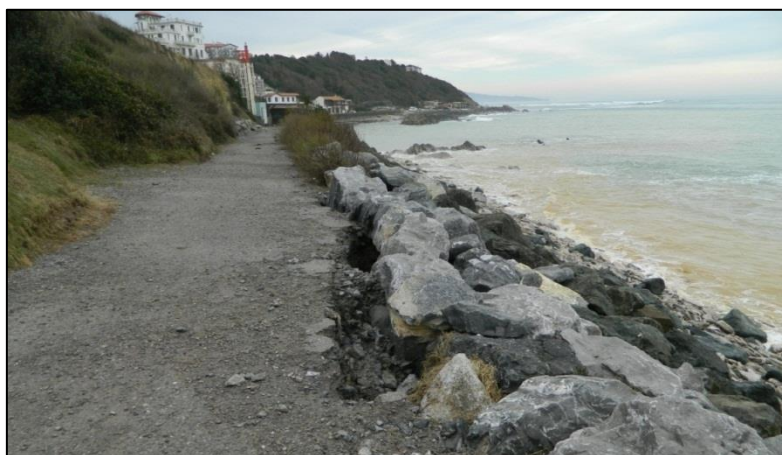
Figure 72 : Déstabilisation des enrochements sur le sentier du littoral de Parlementia (Bidart, 09/01/2014, BRGM).
