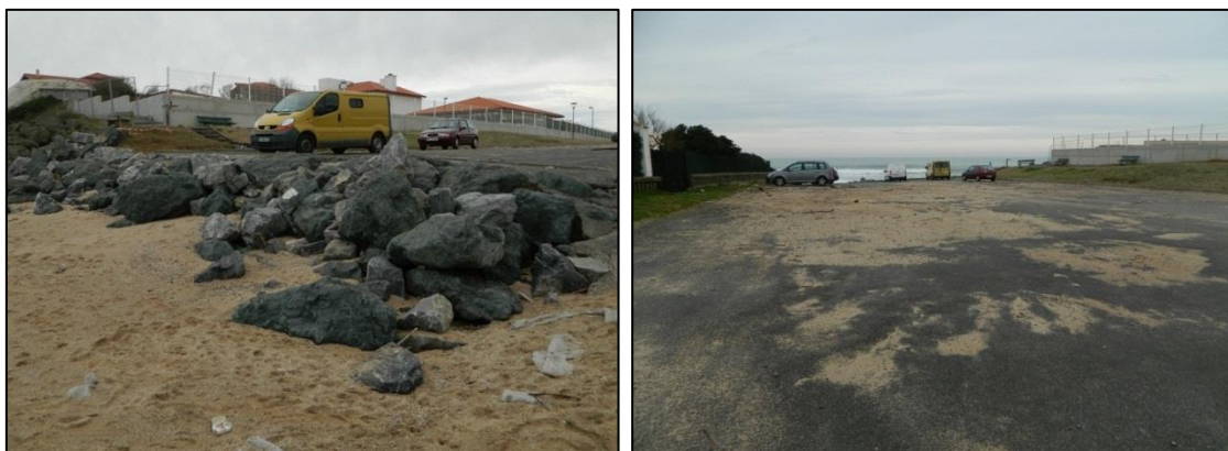
Figure 67 : Gauche : fragilisation des enrochements du parking des Embruns ; Droite : submersion au \frac{3}{4} du parking (Bidart, 09/01/2014, BRGM).
