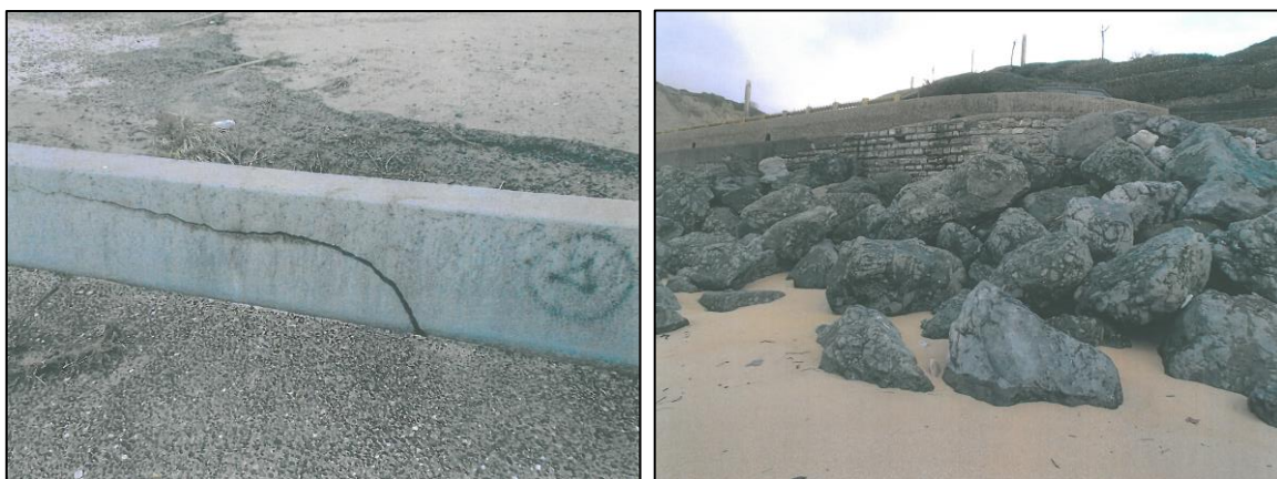
Figure 63 : Gauche : détérioration du parapet en béton à l'extrémité de la promenade ; Droite : fragilisation des enrochements sur la plage avec désolidarisation de plusieurs blocs (Bidart, 07/01/2014, Services Techniques, Mairie de Bidart).
