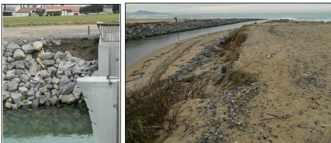
Figure 66 : Fragilisation des enrochements sur la rive droite du débouché de l'Uhabia (Bidart, 09/01/2014, BRGM).
