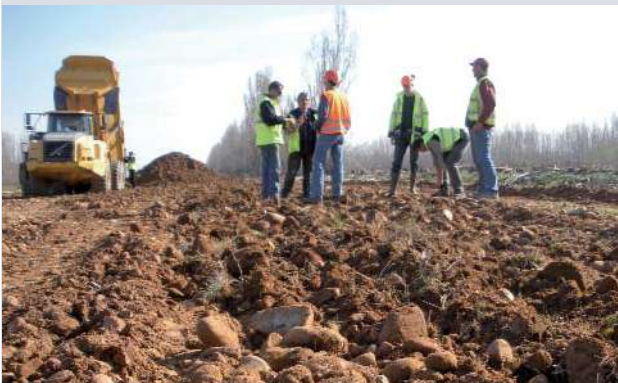
Lors d'un transfert de sol, sur le site de Cossure, propriété de CDC-Biodiversité (Bouches-du-Rhône).
