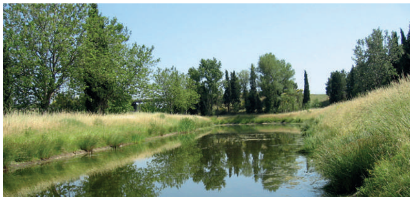
Bassin d'orage autoroutier dans le sud de la France.
