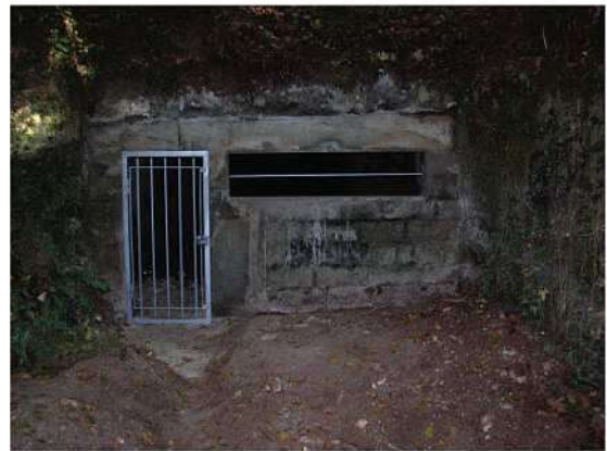
Fermeture de l'entrée d'une carrière permettant le passage des chauves-souris
