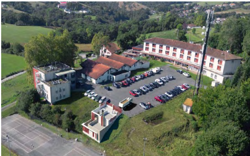
Chaufferie du réseau de chaleur d'Ustaritz ©Dalkia
