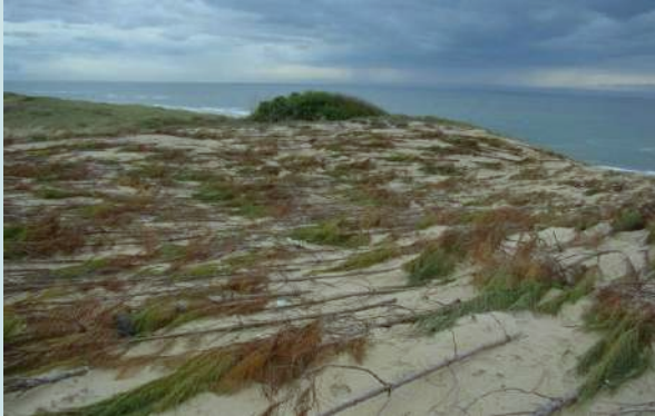
Exemple d'application de la technique de couverture de débris végétaux sur le littoral aquitain, Messanges (40) (ONF, 2008)
