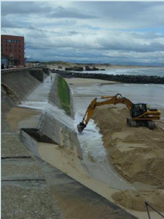
Exemple d'application de la technique de rechargement By-passing hydraulique, Capbreton, plage du Cers (Sogreah, 2008)
