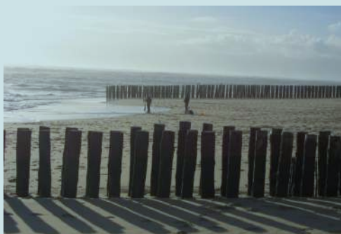
Exemple d'application de la technique Pieux en bois sur le littoral aquitain, Lège Cap-Ferret (33) (GIP Littoral Aquitain, 2008)
