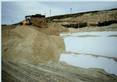
Exemple d'application de la technique panneaux géotextiles en pied de dune sur le littoral aquitain, Biscarrosse (40), (Nicolon, 2000)
