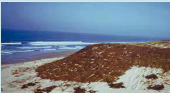
Exemple d'application de la technique de couverture de débris végétaux sur le littoral aquitain, Lège Cap-Ferret (33) (ONF, 1995)
