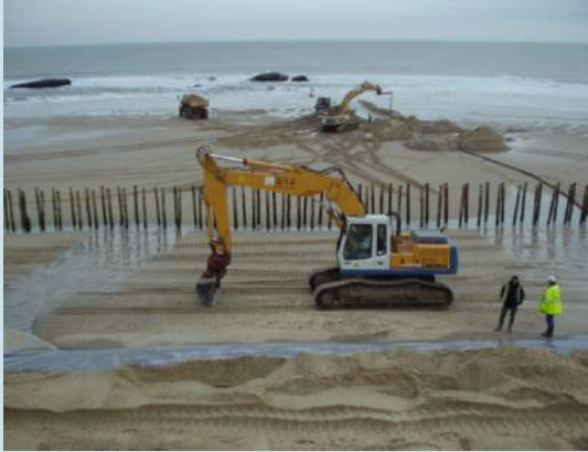
Exemple d'application de la technique de rechargement Back-passing par camion, Soulac-sur-Mer (33). (Gip Littoral Aquitaine, 2009)
