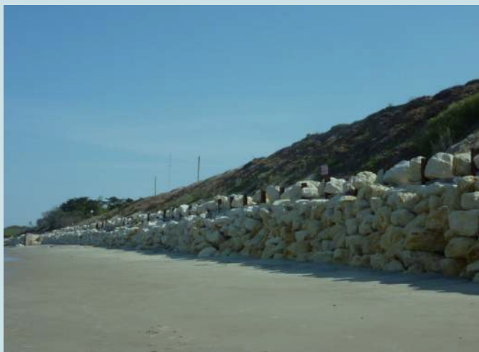
Exemple d'application de la technique Perrés/Murs de haut de plage sur le littoral aquitain, Soulac-sur-Mer (33) (GIP Littoral Aquitain, 2011)
