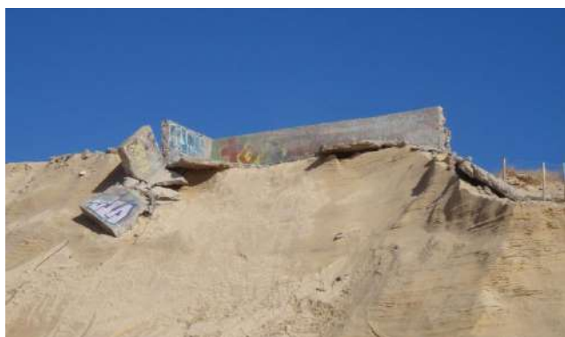
Figure 18 : Blockhaus déstabilisé en haut de dune sur la commune de Lège Cap Ferret (début 2014)
