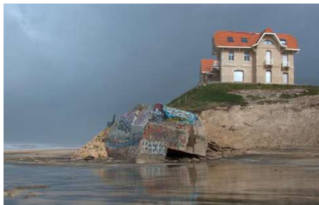
Figure 20 : Blockhaus accentuant l'érosion de la dune (commune de Biscarrosse, début 2014)
