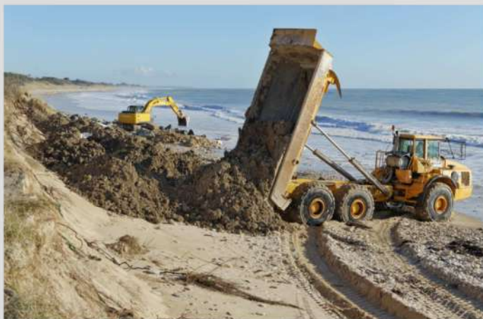
Illustrations 12 et 13 : rechargement du cordon dunaire après les importants dégâts causés par les tempêtes hivernales et restauration de la rivière « Le Tassio » à Sorède : étude et diagnostic hydraulique (Thierry Degen et Laurent Mignaux / Terra)
