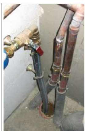
Exemple d'entrées de réseaux à calfeutrer
