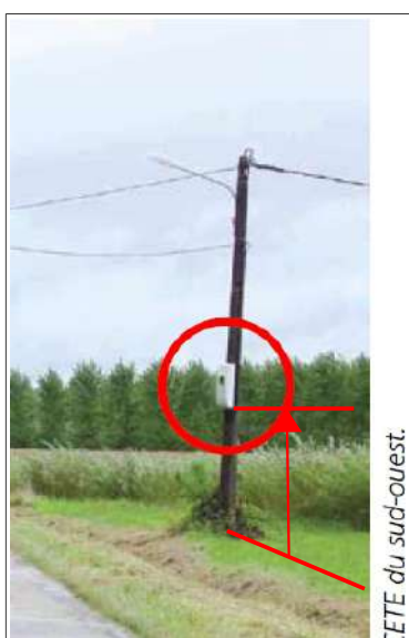
Exemple de mise hors d'eau de compteur électrique
