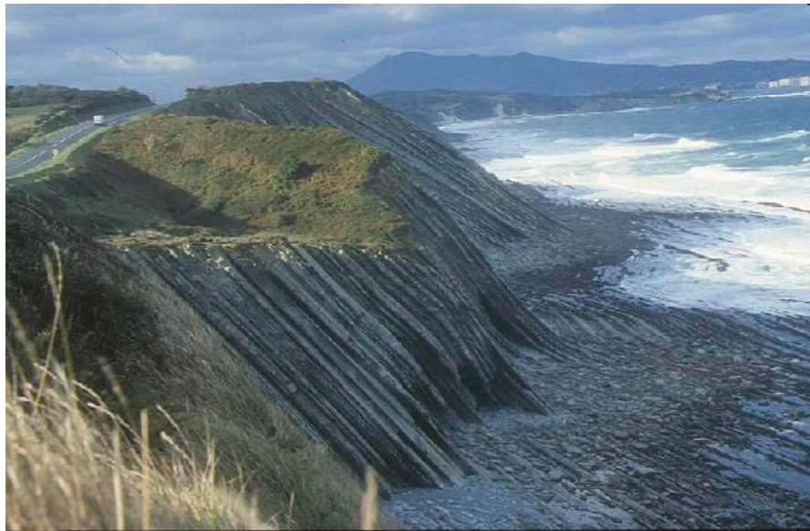
Illustration 6 – Zone propice aux éboulements de type glissements bancs sur bancs (corniche de Urrugne)
