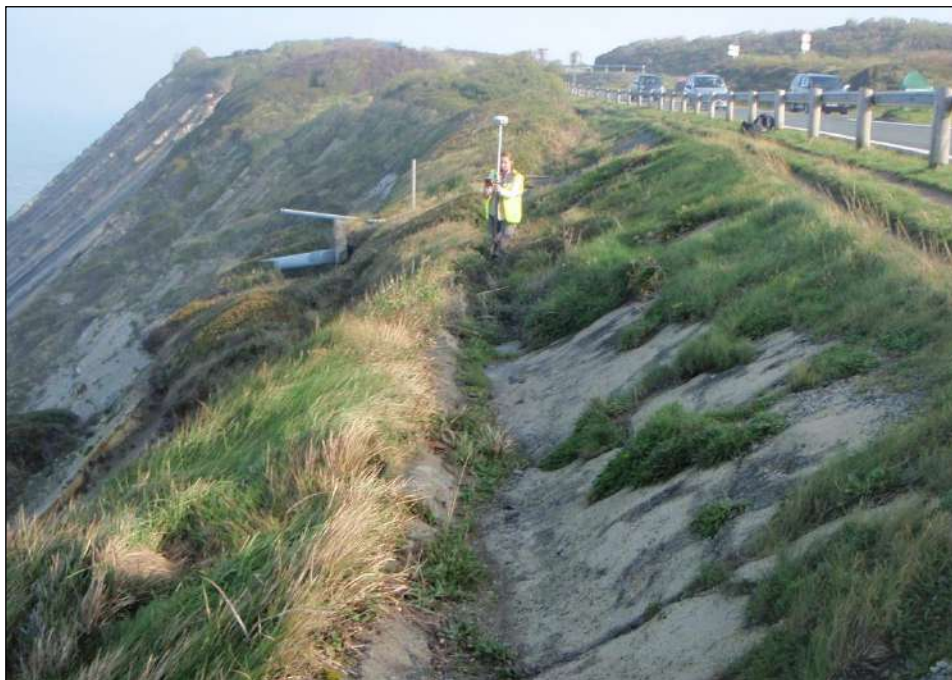
Illustration 38 : Tronçon 7 – levé du fossé bétonné en tête de falaise
