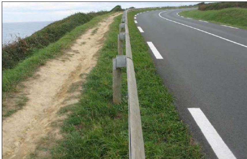
Illustration 32 : Contexte général d'assainissement de la chaussée – tronçon 17
