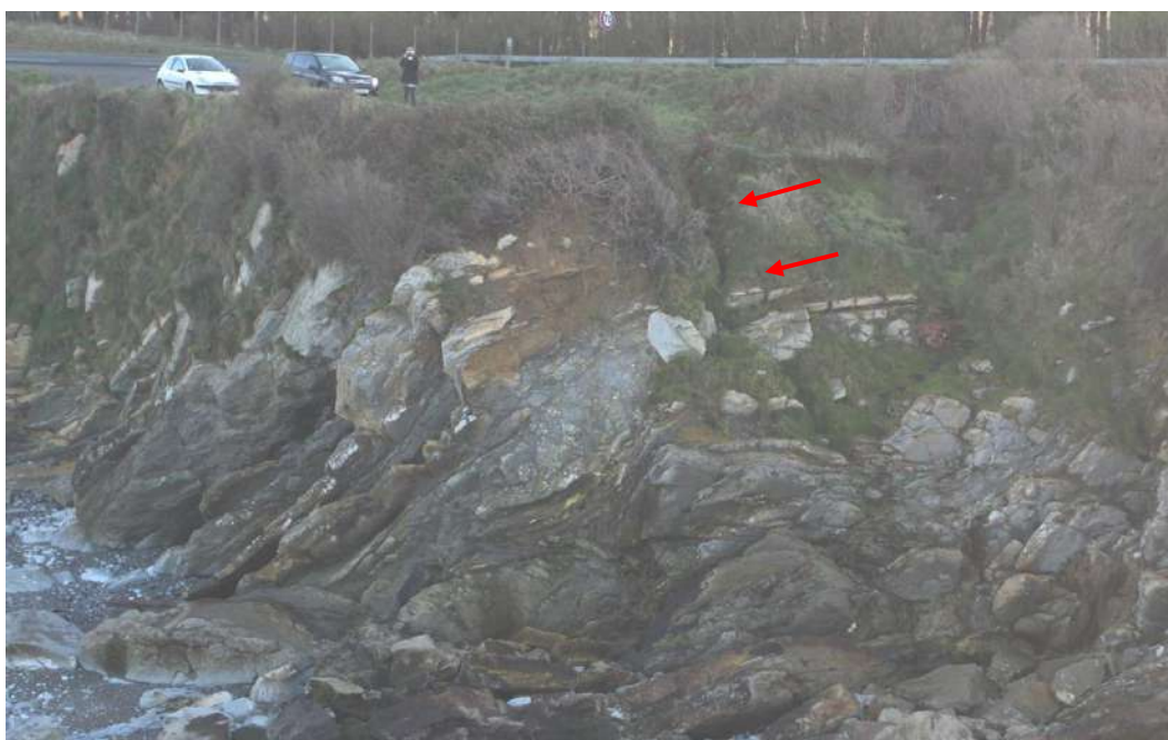
Illustration 37 : Entaille érosive au niveau du point de rejet des eaux pluviales – tronçon 19 (cliché Balloïde Photo, 2012)
