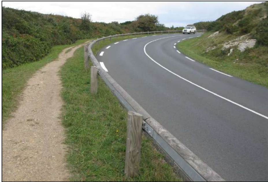
Illustration 24 : Contexte d'assainissement de la chaussée – tronçon 12
