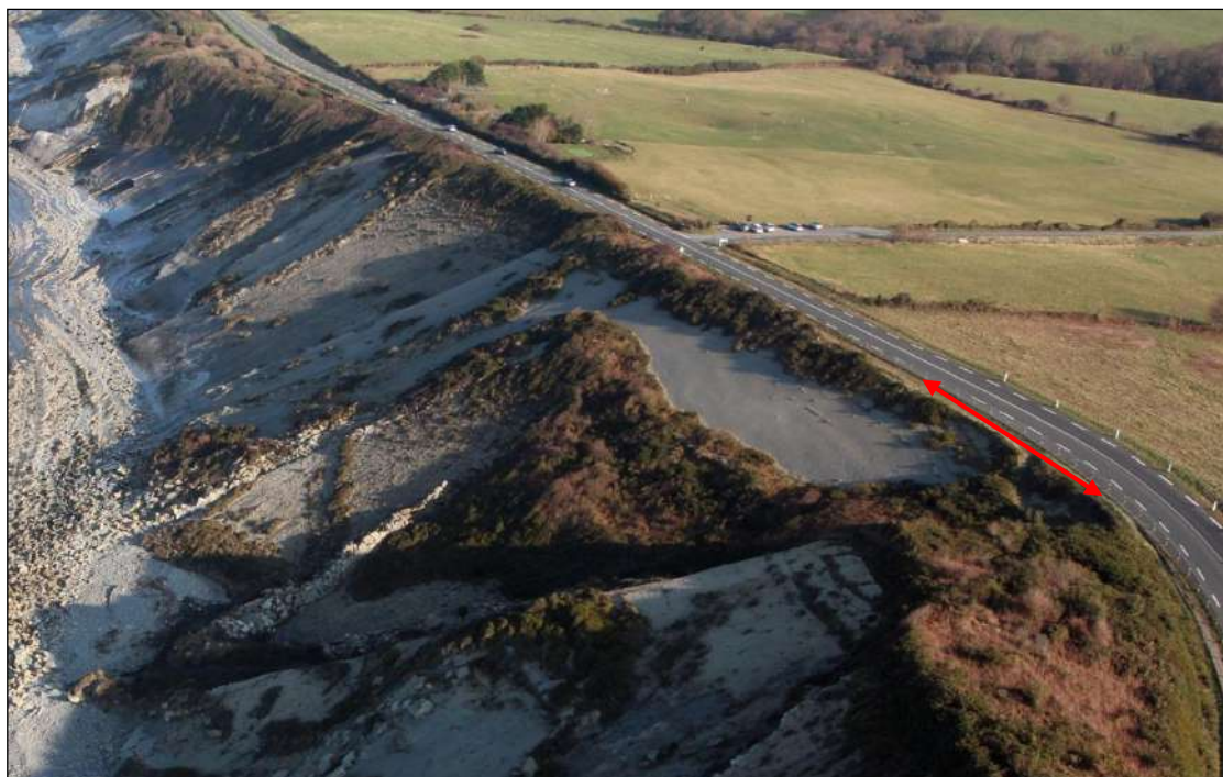
Illustration 26 : Vue générale du tronçon 15 et identification de la zone sur laquelle des rejets direct en tête de falaise d'eaux pluviales sont possibles (cliché Balloïde Photo, 2012)
