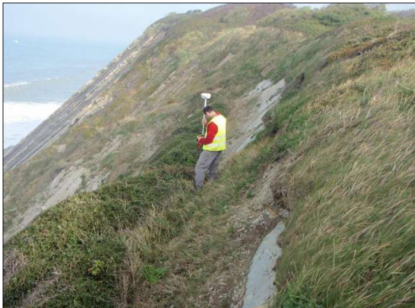
Illustration 39 : Tronçon 7 – levé du panneau affaissé
