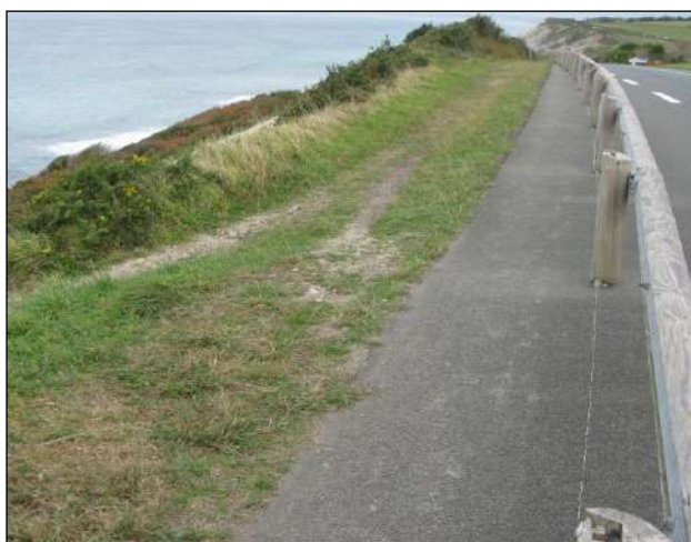
Illustration 28 : A gauche : zone de rejet direct possible en falaise des eaux de ruissellement de voirie, en partie sud du tronçon 12 (absence de talus ou fossé bordant la chaussée côté littoral) ; à droite : banc en cours d'évolution en contrebas de la zone de rejet)
