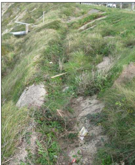
Illustration 17 : Manque d'entretien du fossé bétonné en tête de falaise du tronçon 7 (cliché de gauche : branche sud-ouest , cliché de droite : branche nord-est)
