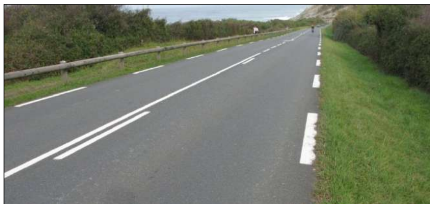
Illustration 27 : Contexte général d'assainissement de la chaussée – tronçon 15
