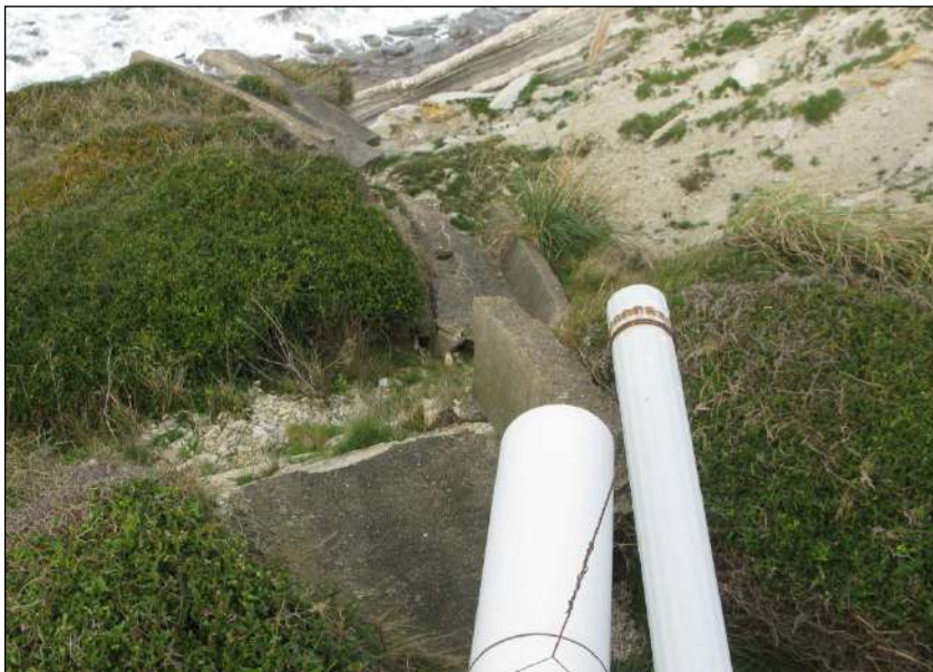
Illustration 20 : caniveau en béton d'évacuation des eaux pluviales en cours de démantèlement - tronçon 7
