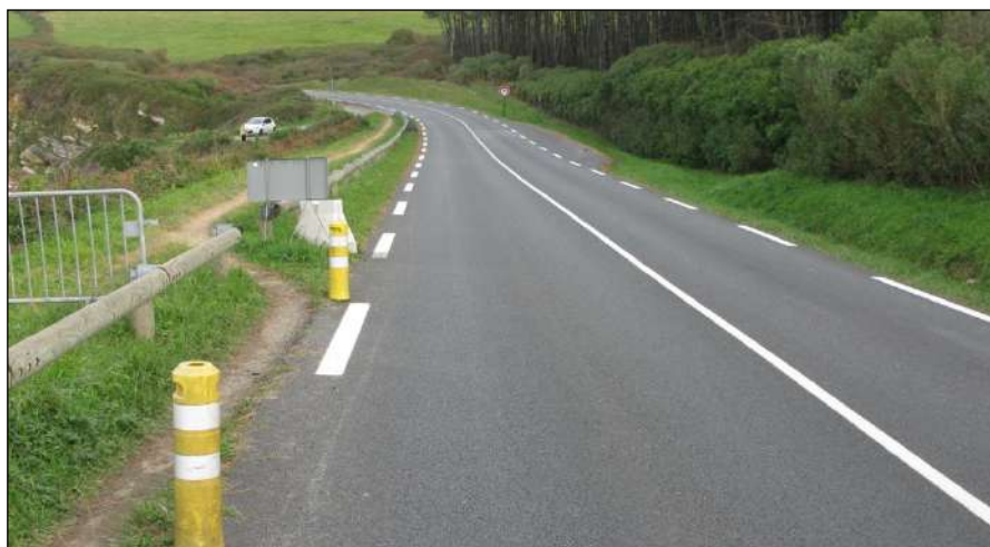
Illustration 35 : Contexte général d'assainissement de la chaussée – tronçon 19
