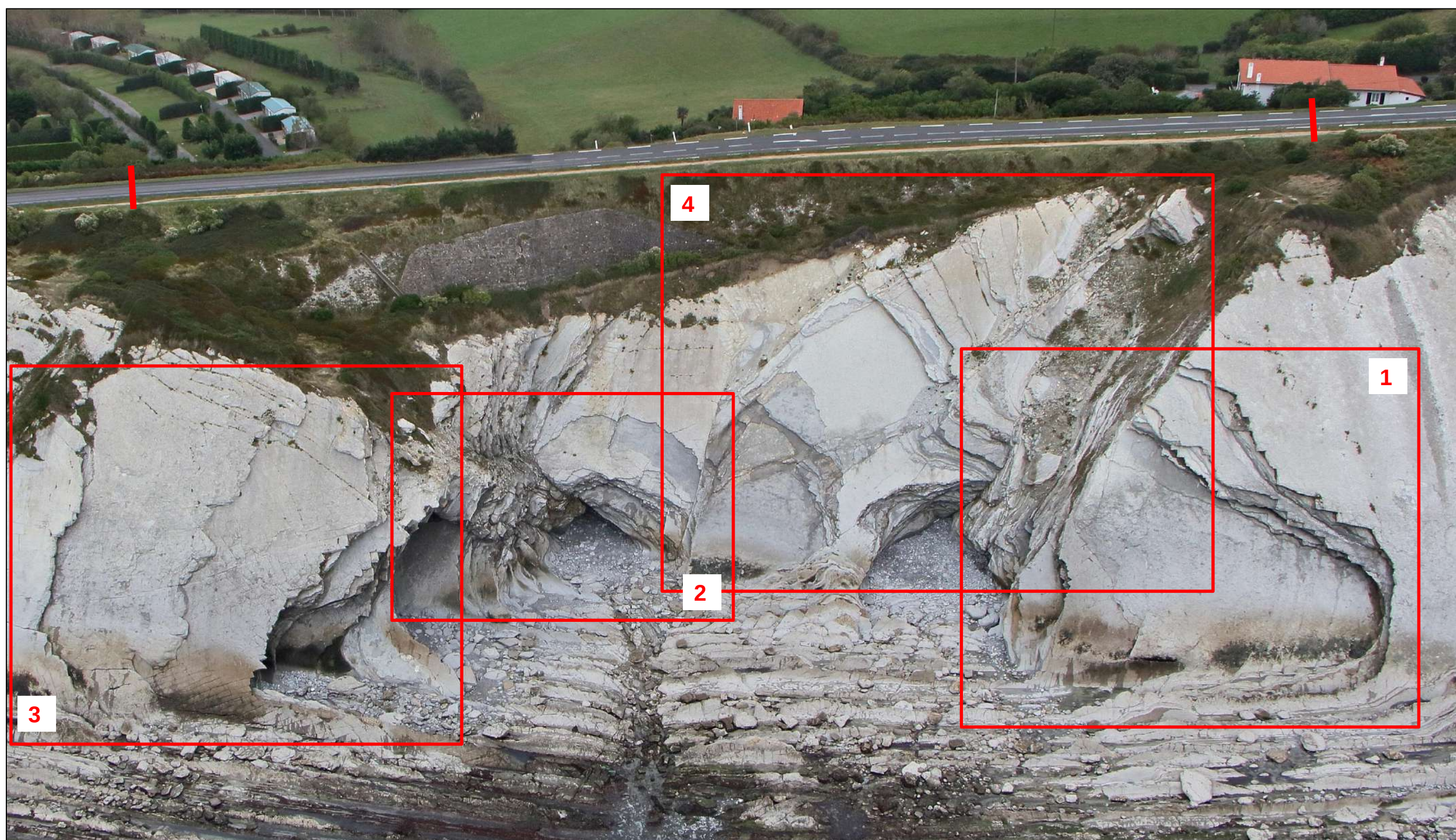
Illustration 23 : Vue générale du tronçon 5 - campagne 18/10/12
