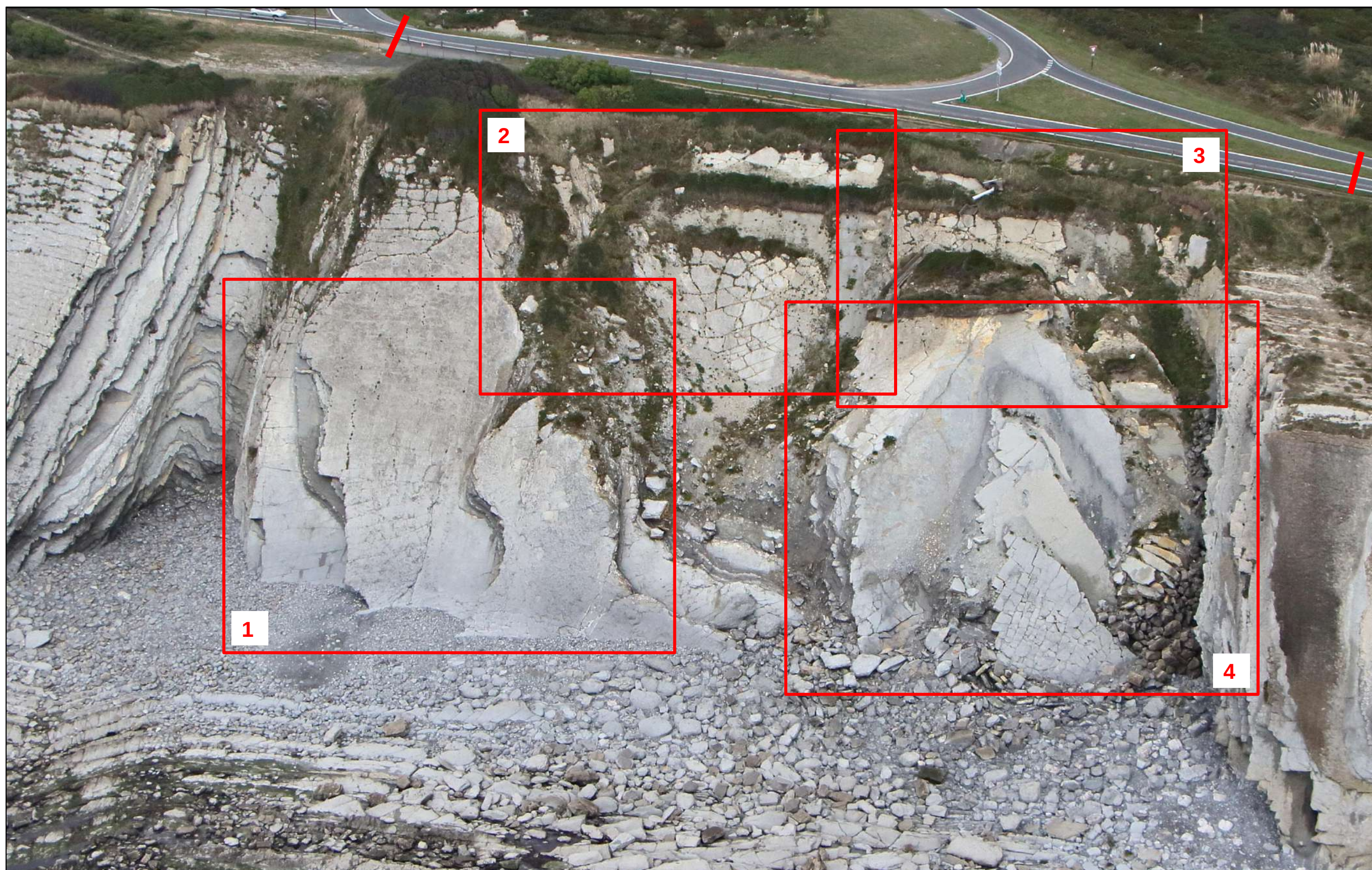
Illustration 29 : Vue générale du tronçon 7 - campagne 18/10/12
