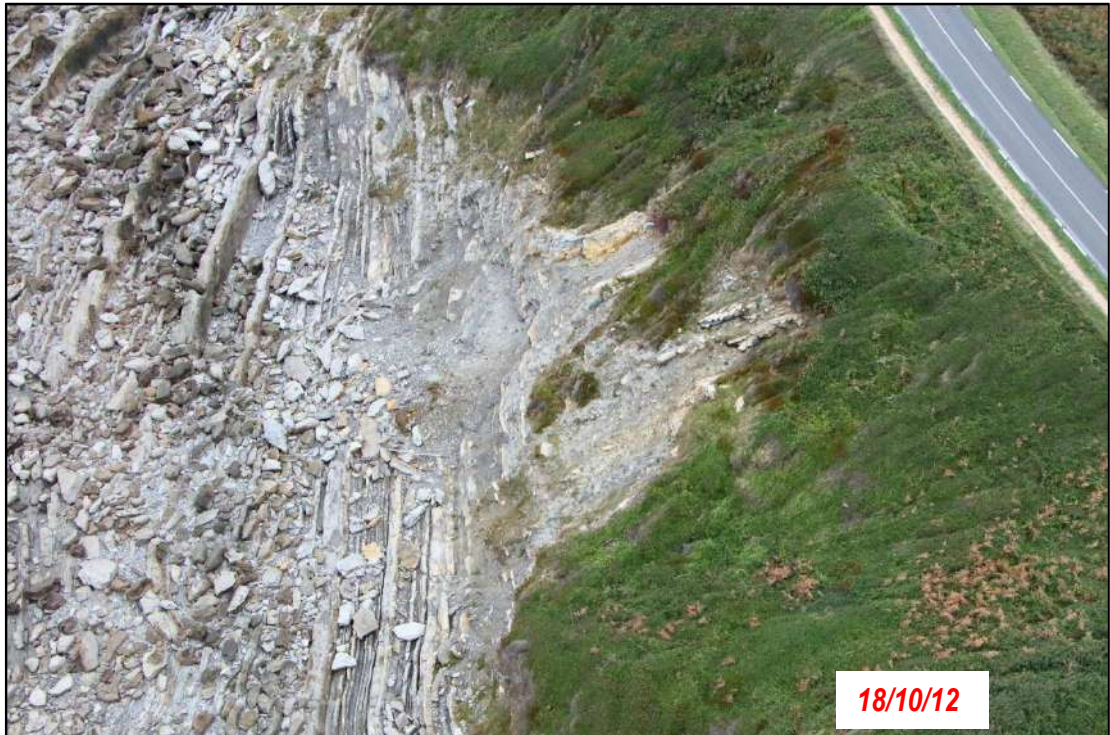
Illustration 56 : Vue de détail zone 1 - tronçon 17
