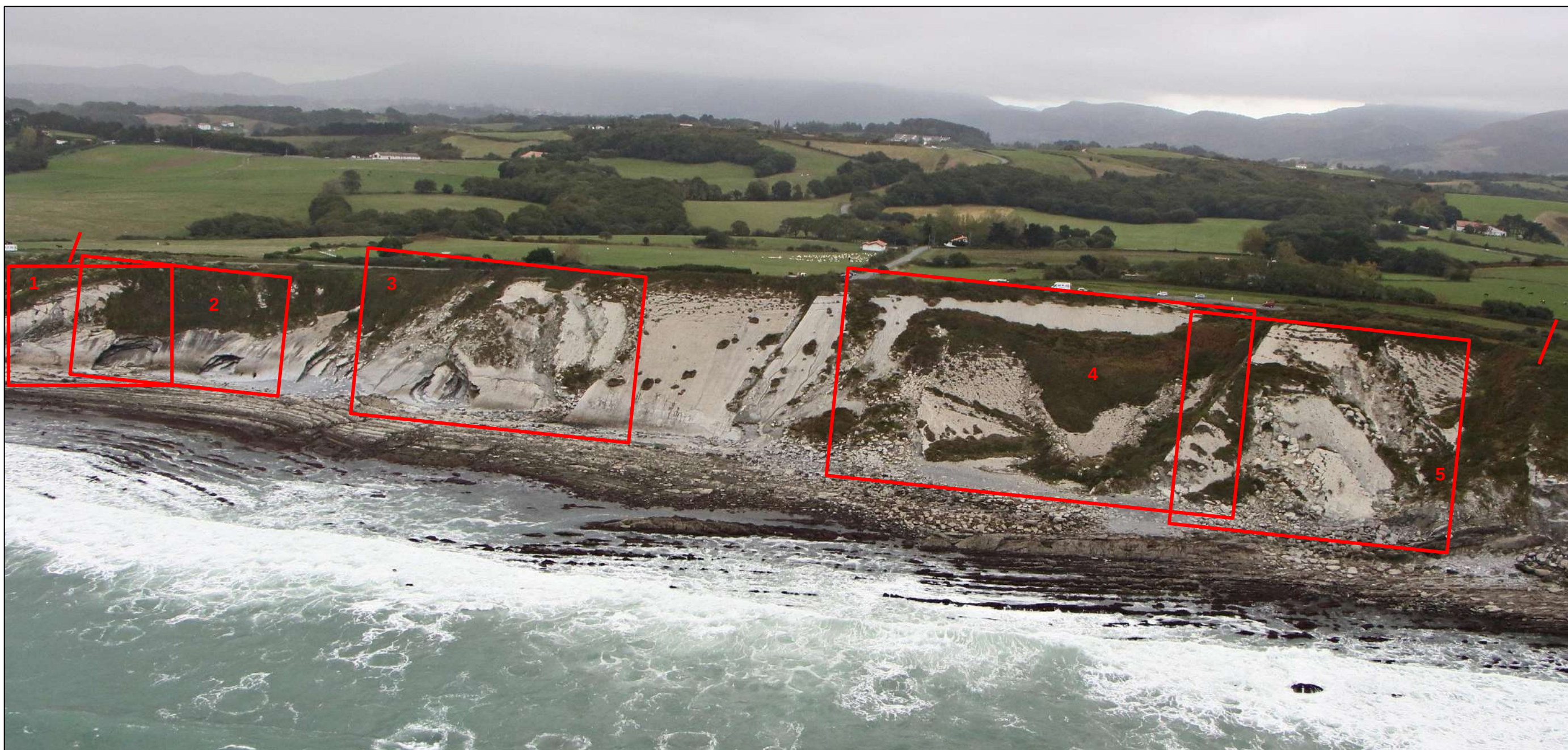
Illustration 48 : Vue générale du tronçon 15 - campagne 18/10/12
