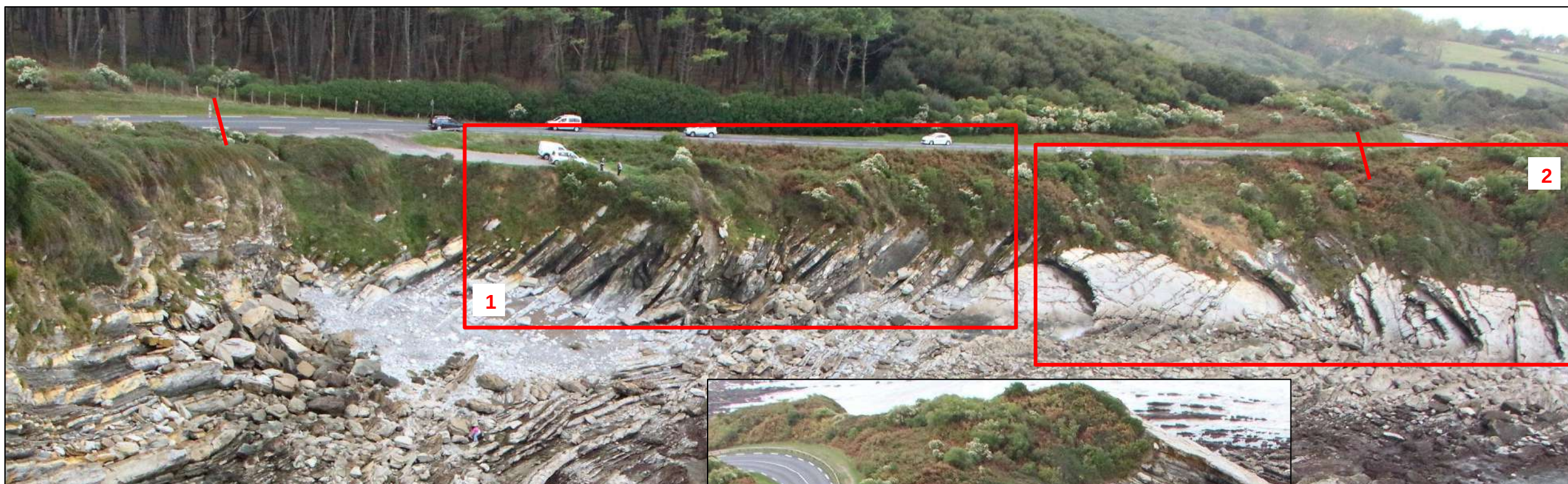
Illustration 59 : Vues générales du tronçon 19 - campagne 18/10/12
