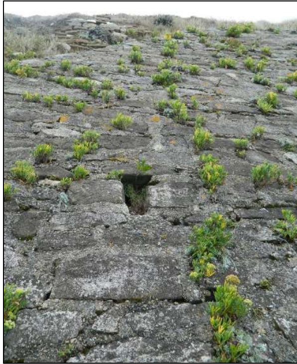
Illustration 22 : Vue de détail du mur de soutènement - tronçon 5
