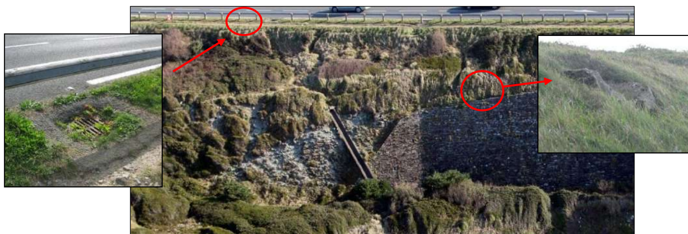
Illustration 20 : Mur de soutènement en partie haute de falaise – tronçon 5
