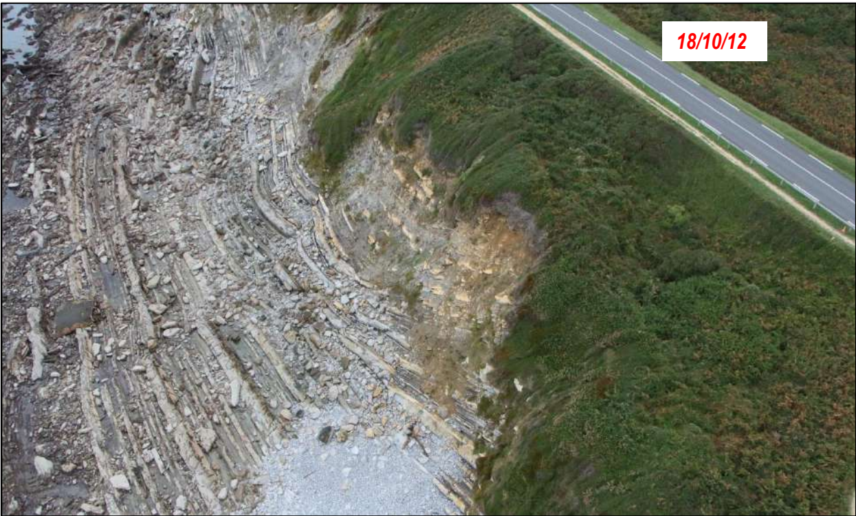
Illustration 58 : Vue de détail zone 2 - tronçon 17
