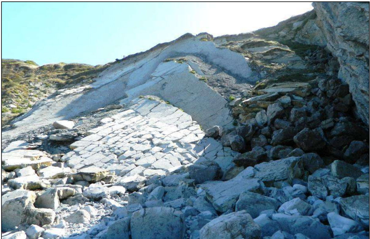
Illustration 28 : Panneaux en cours de démantèlement au droit du tronçon 7 - cliché 19/09/12 (cf. vues de détail zone 4)
