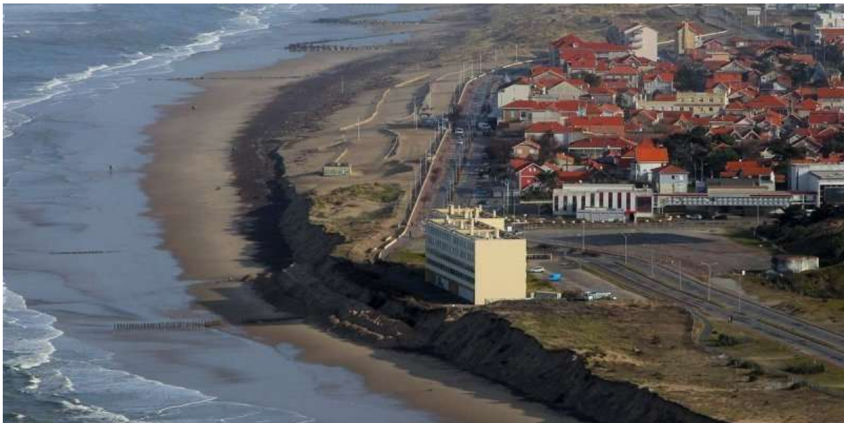
Figure 7 : L'immeuble Le Signal à Soulac-sur-Mer, en janvier 2014 (Crédit photo : Laurent Theillet ; Source : www.sudouest.fr )
