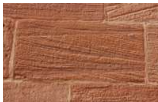
Grès rouge du Trias, roche traditionnelle de construction dans les Vosges et en Alsace
