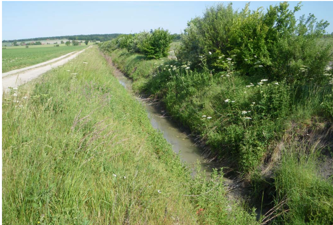
Photo 5 – Fossé profond à eau stagnante à peu courante au « Marais »
