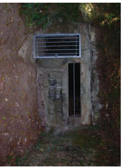
Fermeture de l'entrée d'une carrière permettant le passage des chauves-souris
