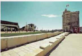
1. Secteur du Square de l'Armide : l'ouvrage de protection est composé de murets, de bancs dont l'assise se relève, et de batardeaux qui s'appuient sur des bâtiments existants
