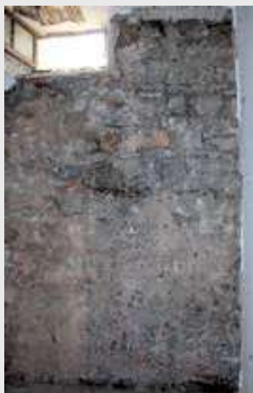
Proceso de ejecución de una de las catas en la fachada del conjunto de Olaberria (Legazpi), y detalle del paramento interior de la ferrería totalmente ennegrecido. A. MORAZA
