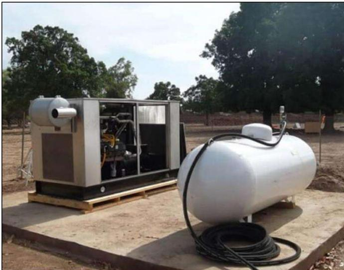
*Petite centrale électrique de Bourakébougou, comportant un moteur de camion Ford modifié pour fonctionner directement avec de l'hydrogène, couplé à un générateur d'électricité de 35 KV qui fournit 7 KW et qui n'a que de l'eau pure comme résultat de la combustion ! Et ce, avec un très faible coût de production. Une partie du village est éclairée par cette électricité très peu polluante. Source Hydroma*
