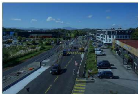
Travaux du Tram'Bus en cours de réalisation entre Saint-Léon et Technocité (achevés à fin 2023)
