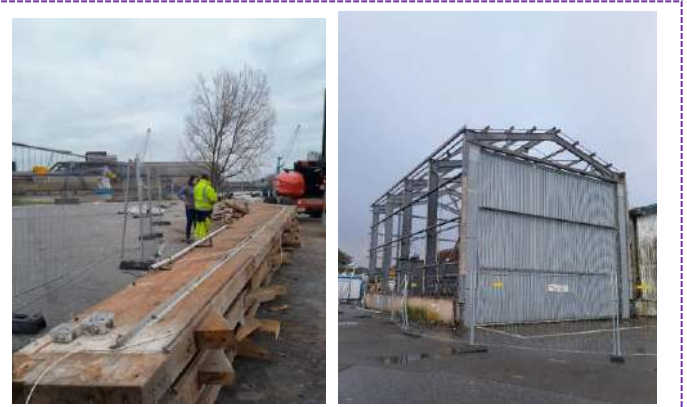
Figure 2 - Déconstruction sélective Port du Brise-Lames d'Anglet
