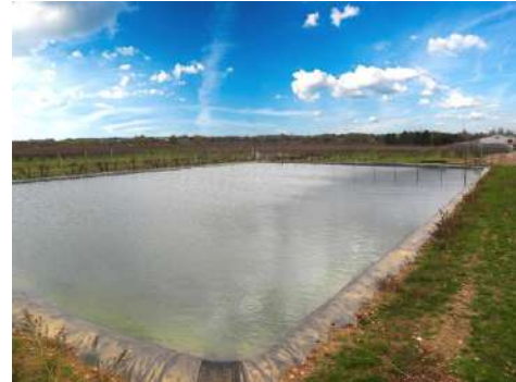
Bassin de stockage d'eau de pluie. Crédit
