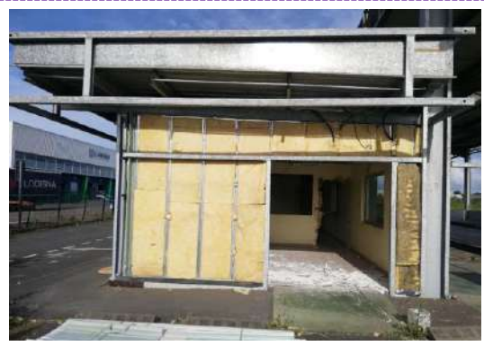
Figure 1 - Déconstruction sélective de l'ancien centre de contrôle poids lourds du CEF de Mouguerre
