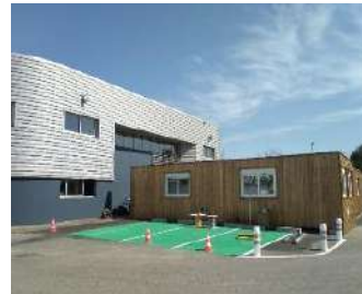
IRVE à la station d'épuration du Pont de l'Aveugle à Anglet
