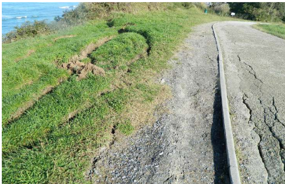
Illustration 42 - Site 3 du secteur d'Erromardie : désordres observables en arrière de la tête de versant et sur le sentier littoral suite au glissement de décembre 2021 (©Observatoire de la côte de Nouvelle-Aquitaine, décembre 2021)
