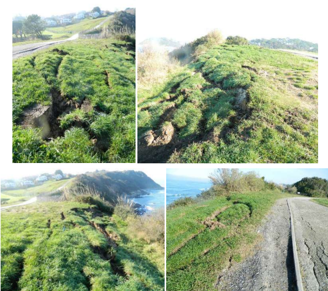
Illustration 36 - Glissement d'Erromardie Ouest, en décembre 2021 ; niches d'arrachements, panneaux affaissés en sommet de versant et désordres sur le sentier littoral (clichés 16/12/2021, RP-72047-FR)
