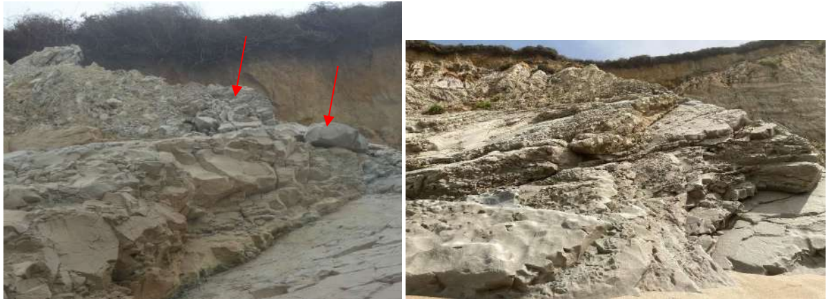
Illustration 6 - Evolution du secteur avant (à gauche) et après purges (à droite) (site 5 ; ©OCNA)
