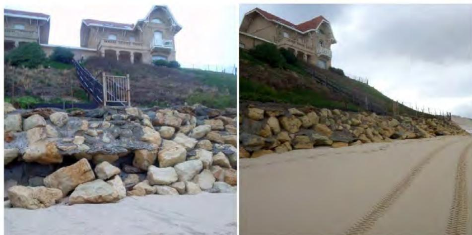
Figure 18 - Comparaison du niveau de plage, au droit des villas jumelles de la plage Centrale, à un an d'intervalle : le 23/11/2022 (à gauche) et le 06/11/23 (à droite) © CdC Grands Lacs
