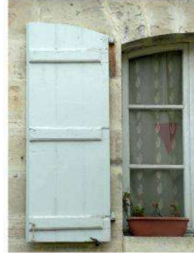
Menuiseries en bois en vantaux ouvrants à la française, en applique intérieure de l'encadrement
