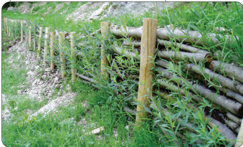
Figure 2.17. La palissade, ouvrage de génie végétal, installée ici dans le massif du Vercors (Drôme).
