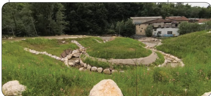
Figure 2.8. Contournement de seuil sur le Guiers, en Savoie. La pente du cours d'eau, adoucie, permet aux poissons de circuler de part et d'autre du seuil.
