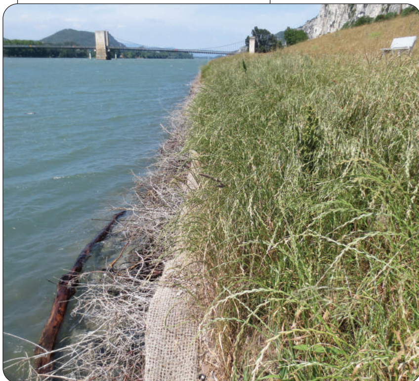
Figure 2.5. Végétalisation des berges du Rhône dans la commune de Donzère (Drôme). Des semis ont été effectués sur un géofilet biodégradable en toile de jute.
