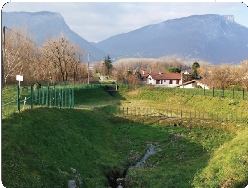
Figure 2.12. Bassin de rétention d'eau et de matériaux végétalisés, sur la commune de Voreppe, au pied du massif de la Chartreuse.
