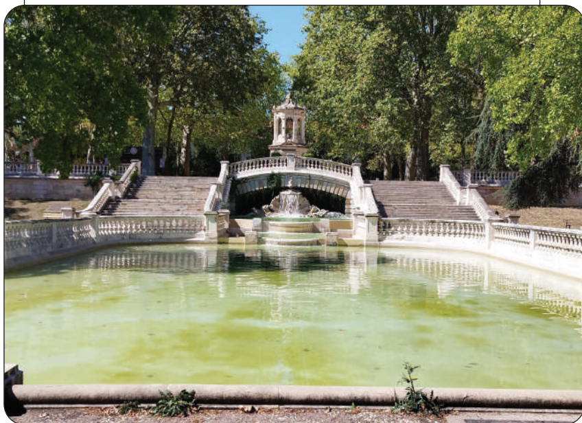
Figure 4.9. La ville de Dijon, en Côte-d'Or, a depuis très longtemps opté pour une récupération d'eau de pluie, stockée dans des bassins comme celui-ci, pour l'arrosage de ses espaces verts.
