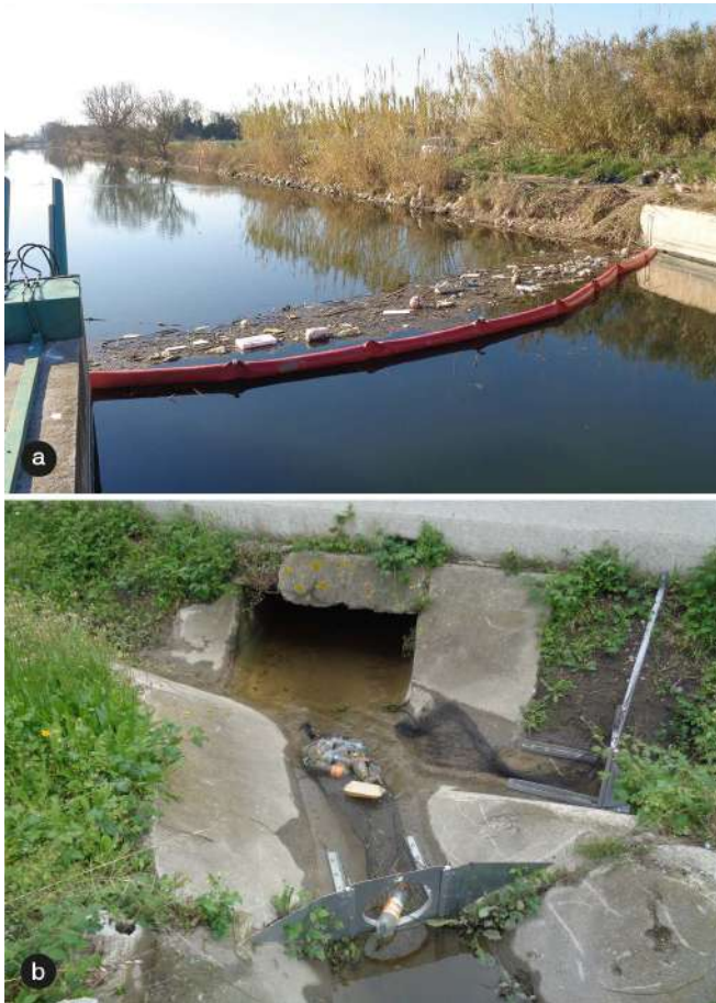
Figure 1.2.3. Dispositif de piégeage des déchets « en amont » mis en place dans les Pyrénées-Orientales (plaine du Roussillon). a) Boudin flottant sur le canal (drainage des eaux de plaine) (la Llabanère, 2020). b) Filets de Clean Up Rivers installés dans un fossé (Canet-en-Roussillon, 2020).
