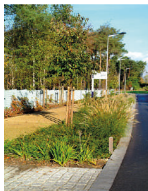
Exemples de réalisation de voirie avec noues plantées attenantes pour une gestion par infiltration des eaux pluviales. © Banque de photos INFRA Services
