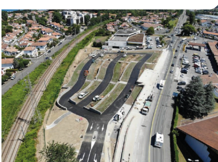
Le parking relais Ilargia à Saint-Jean-de-Luz et la plage d'Errorardie au fond. Point central de la gestion des flux touristiques à Saint-Jean-de-Luz Nord. © ville de Saint-Jean-de-Luz.
