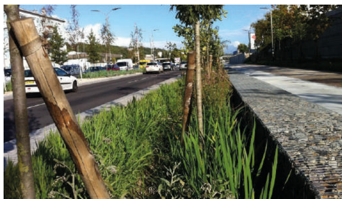
Exemples de réalisation de voirie avec noues plantées attenantes pour une gestion par infiltration des eaux pluviales. © Banque de photos INFRA Services
