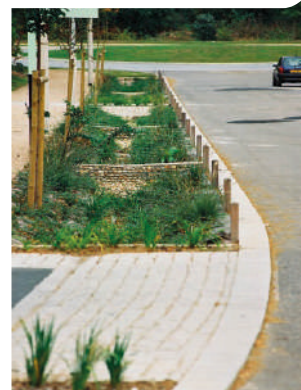
Exemples de réalisation de voirie avec noues plantées attenantes pour une gestion par infiltration des eaux pluviales. © Banque de photos INFRA Services
