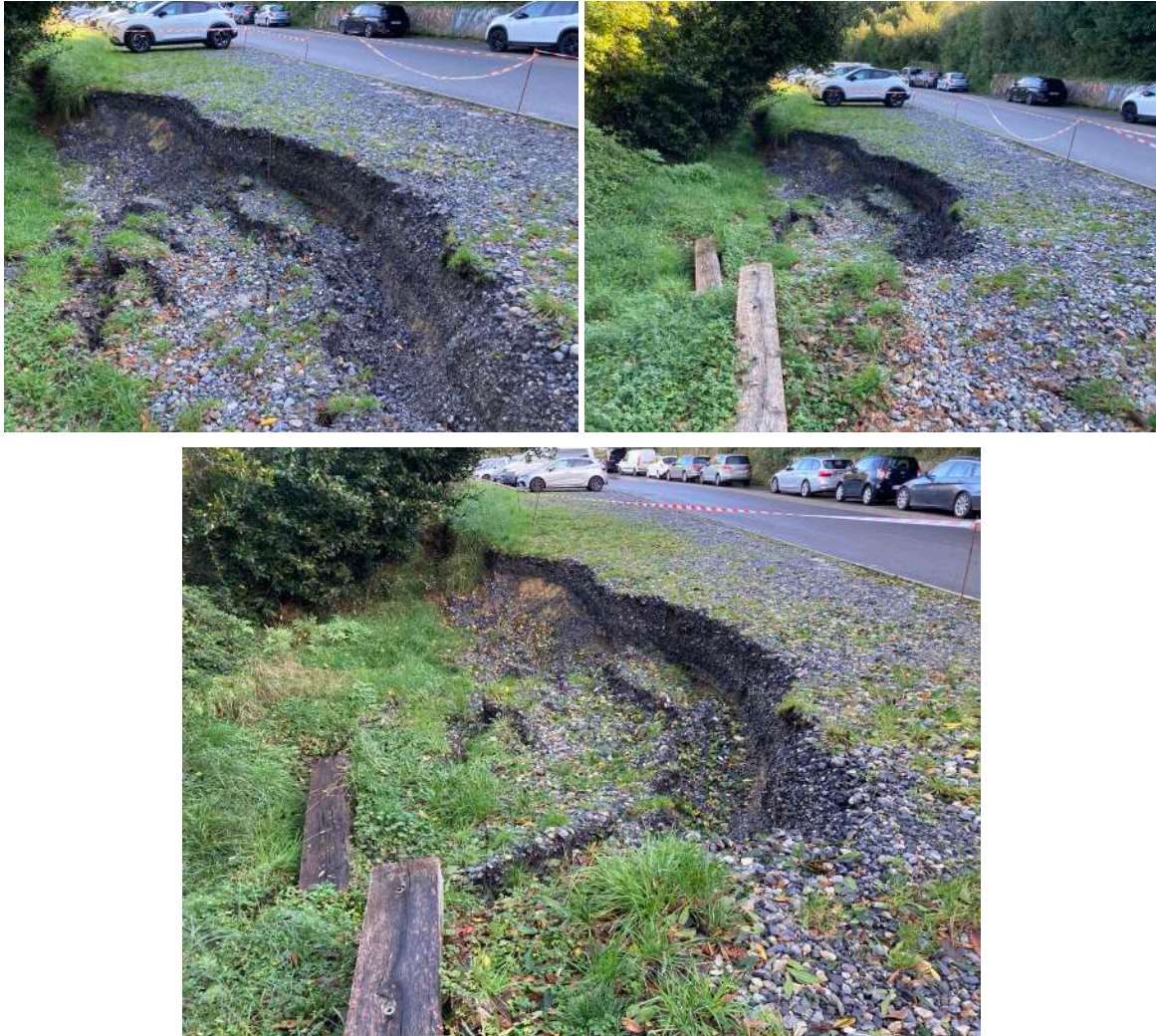
Illustration 24 - Glissement de terrain survenu sur le parking d'Erretegia : photos du haut prises le 23/10/2024 et photo du bas le 16/12/2024) (©BRGM)
