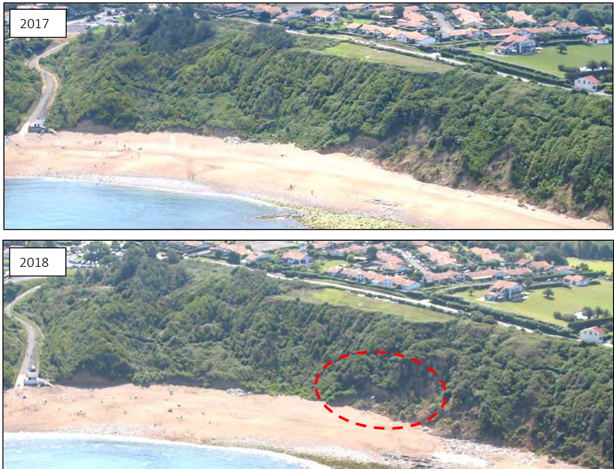
Illustration 35 - Glissement en partie centrale du secteur de Lafiténia, évolution entre 2017 et 2018 (©Observatoire de la Côte Aquitaine, Olivier Chaldebas, ULM Sud Bassin, 2017 et 2018)
