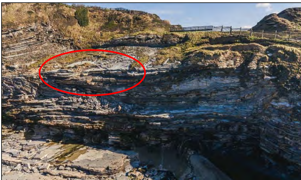
Illustration 56 - Dalles concernées par la rupture survenue entre 2017 et 2019, pour un volume de 59 m 3 , dans le secteur de Sainte-Barbe (@Observatoire de la Côte Aquitaine, Com' by AVM, 2016)
