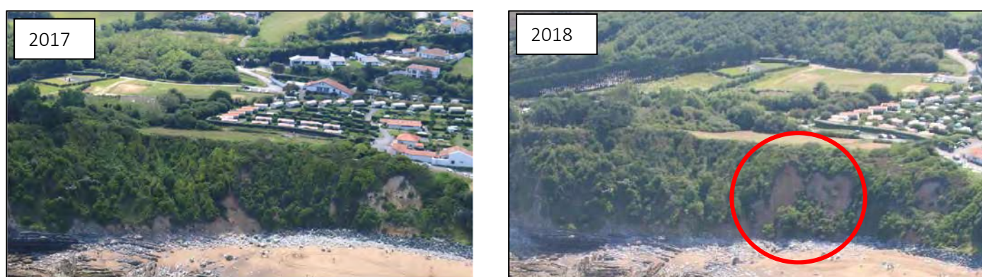
Illustration 28 - Glissement en partie est de Mayarko, survenu entre 2017 et 2018 (@Observatoire de la Côte Aquitaine, Olivier Chaldebass, ULM Sud Bassin, 2017 et 2018)
