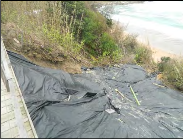
Illustration 32 - Zone d'arrachement en partie haute de versant du glissement du Bibambar, à Mayarko, en janvier 2018 (clichés avril 2018 ; ©Observatoire de la Côte Aquitaine)
