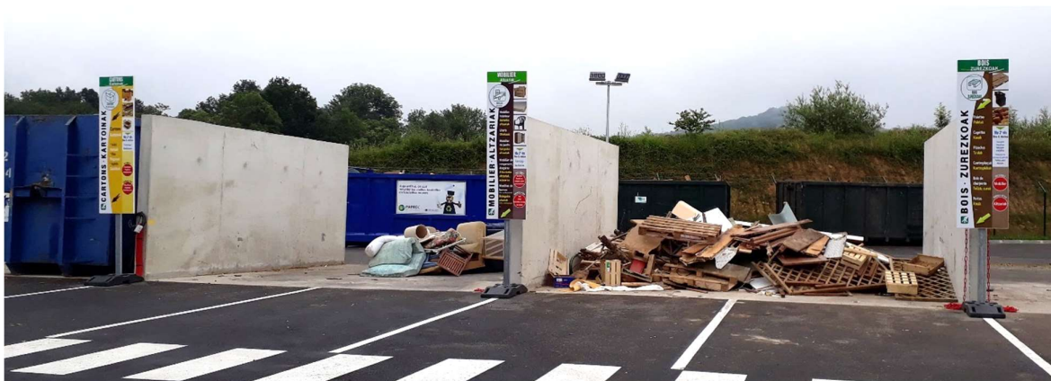
Déchèterie à plat de Saint Jean le Vieux
