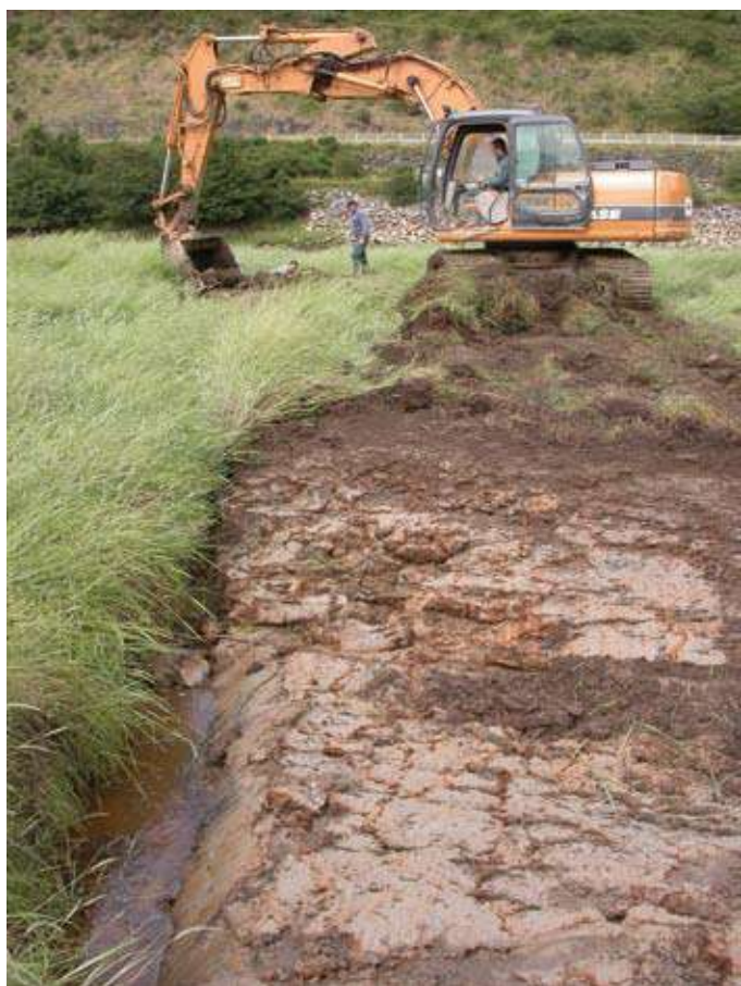
Photo 22 - Le bouchon argileux a été confectionné à partir d'argile prélevé sur un bord du fossé et selon un profil un pente douce de manière à obtenir une mare favorable au développement de ceintures de végétation aquatique.
